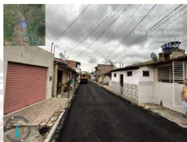
FOTO 2: PAVIMENTAÇÃO ASFÁLTICA EXECUTADA;
