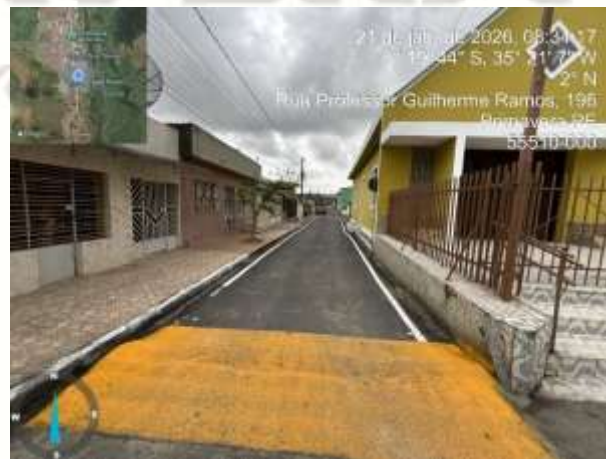
FOTO 12: SINALIZAÇÃO HORIZONTAL EXECUTADA;
