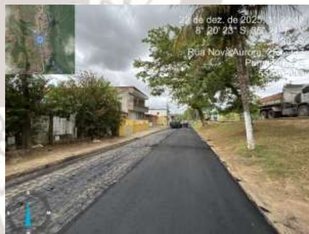
FOTO 10: PAVIMENTAÇÃO ASFÁLTICA EXECUTADA;
