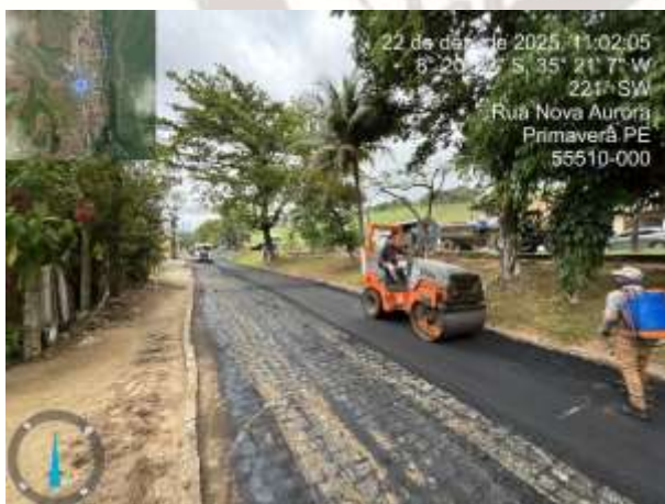
FOTO 09: PAVIMENTAÇÃO ASFÁLTICA EXECUTADA;
