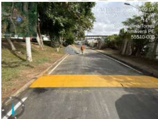
FOTO 11: SINALIZAÇÃO HORIZONTAL EXECUTADA;
