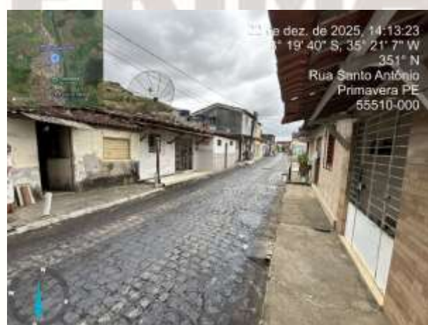
FOTO 5: PINTURA DE LIGAÇÃO EXECUTADA;
