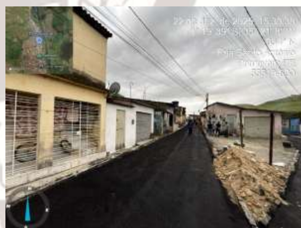
FOTO 4: PAVIMENTAÇÃO ASFÁLTICA EXECUTADA;
