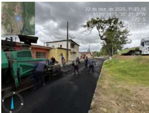
FOTO 7: PAVIMENTAÇÃO ASFÁLTICA EXECUTADA;
