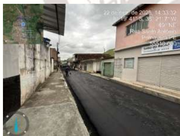
FOTO 3: PAVIMENTAÇÃO ASFÁLTICA EXECUTADA;
