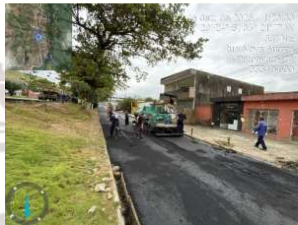
FOTO 8: PAVIMENTAÇÃO ASFÁLTICA EXECUTADA;
