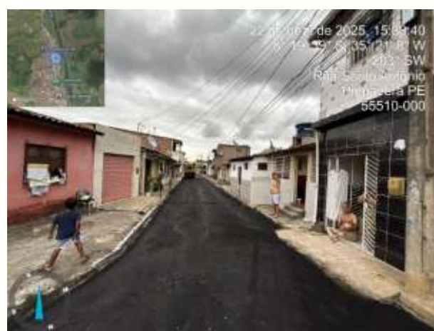
FOTO 1: PAVIMENTAÇÃO ASFÁLTICA EXECUTADA;
