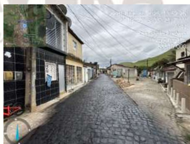
FOTO 6: PINTURA DE LIGAÇÃO EXECUTADA;
