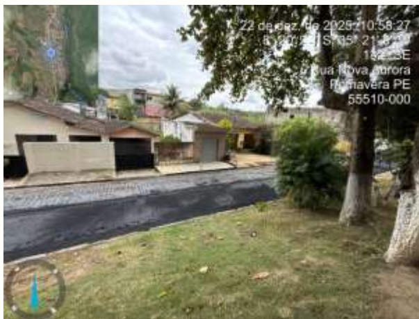
FOTO 7: PAVIMENTAÇÃO ASFÁLTICA EXECUTADA;
