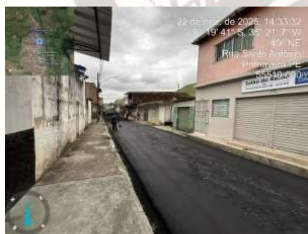
FOTO 3: PAVIMENTAÇÃO ASFÁLTICA EXECUTADA;
