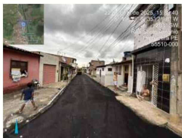
FOTO 1: PAVIMENTAÇÃO ASFÁLTICA EXECUTADA;
