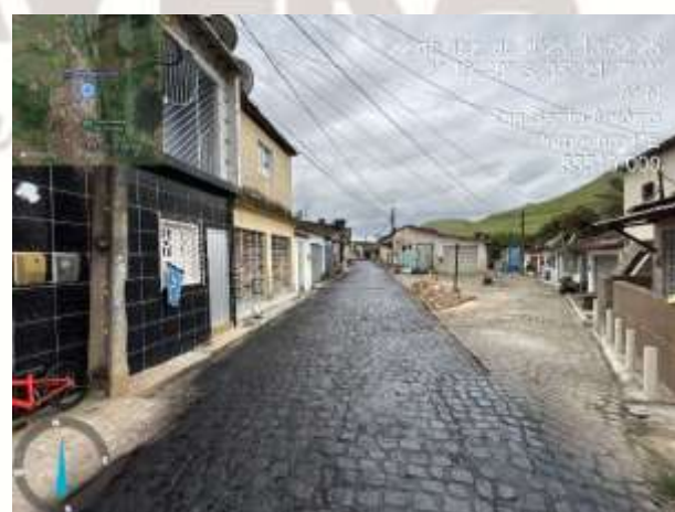
FOTO 6: PINTURA DE LIGAÇÃO EXECUTADA;
