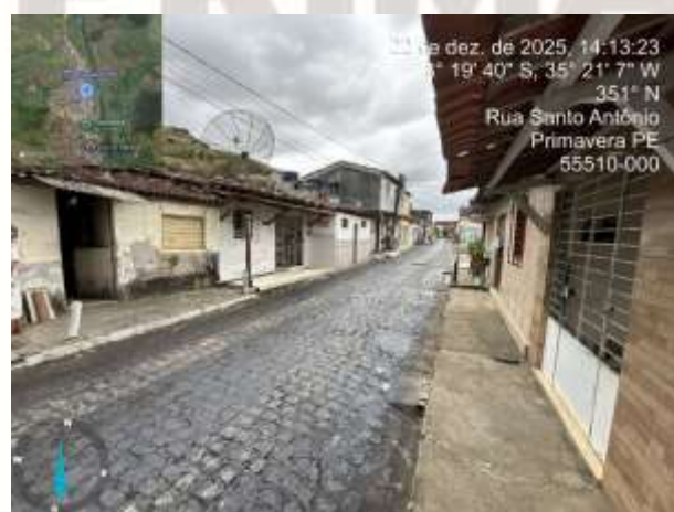
FOTO 5: PINTURA DE LIGAÇÃO EXECUTADA;
