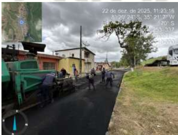
FOTO 11: PAVIMENTAÇÃO ASFÁLTICA EXECUTADA;
