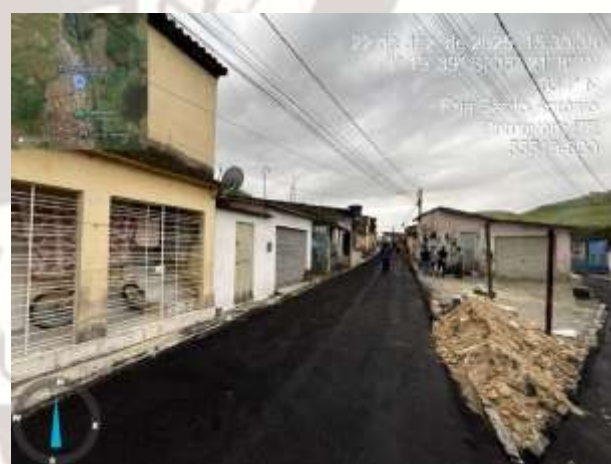
FOTO 4: PAVIMENTAÇÃO ASFÁLTICA EXECUTADA;
