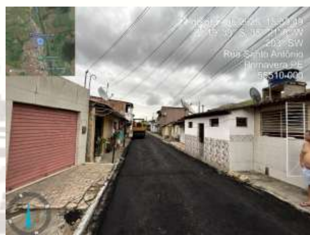
FOTO 2: PAVIMENTAÇÃO ASFÁLTICA EXECUTADA;
