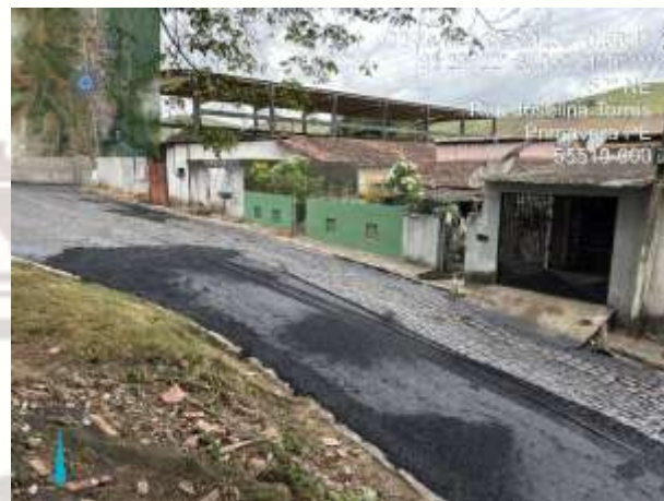
FOTO 8: PAVIMENTAÇÃO ASFÁLTICA EXECUTADA;
