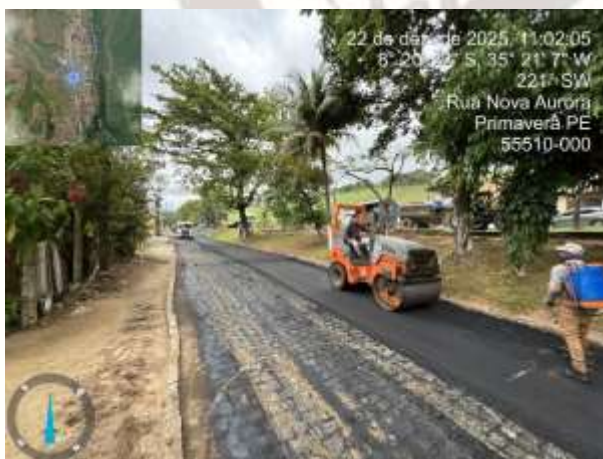
FOTO 09: PAVIMENTAÇÃO ASFÁLTICA EXECUTADA;
