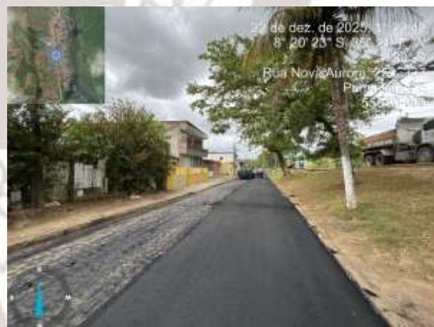
FOTO 10: PAVIMENTAÇÃO ASFÁLTICA EXECUTADA;
