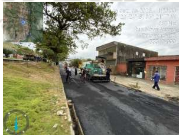
FOTO 12: PAVIMENTAÇÃO ASFÁLTICA EXECUTADA;
