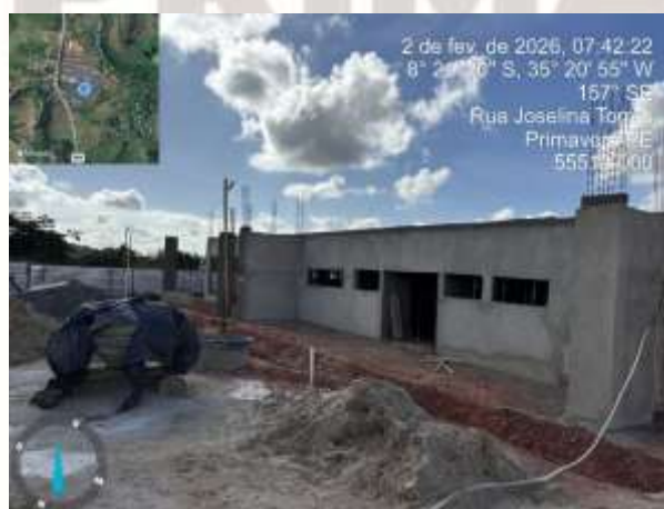
FOTO 11: Reboco externo executado;
