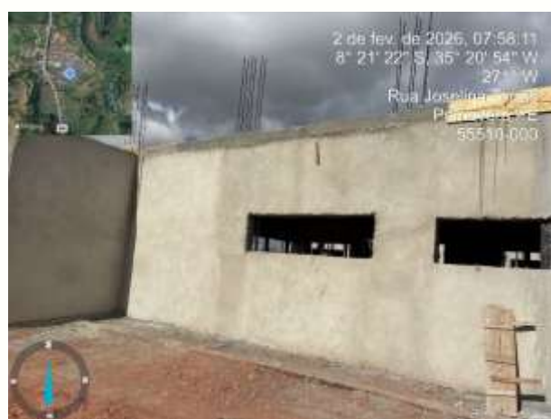
FOTO 1: Reboco externo executado;
