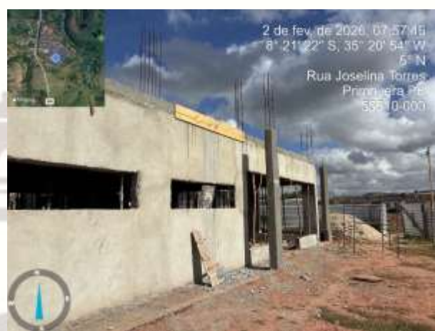
FOTO 2: Reboco externo executado;
