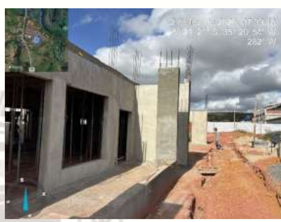
FOTO 8: Reboco externo executado;
