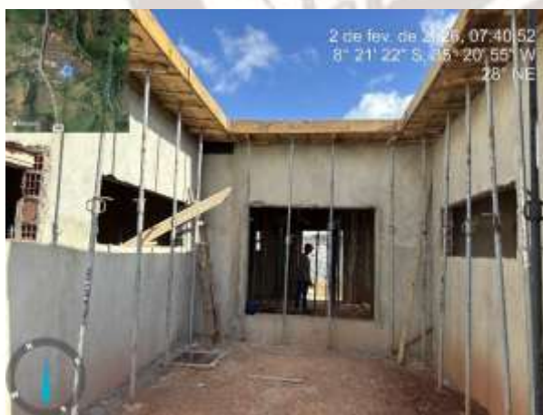
FOTO 09: Reboco externo executado;
