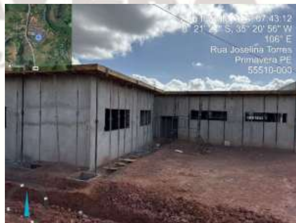
FOTO 12: Reboco externo executado;
