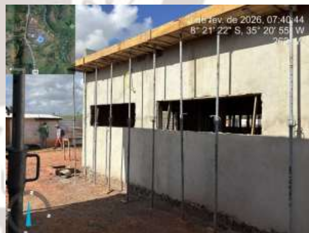
FOTO 10: Reboco externo executado;
