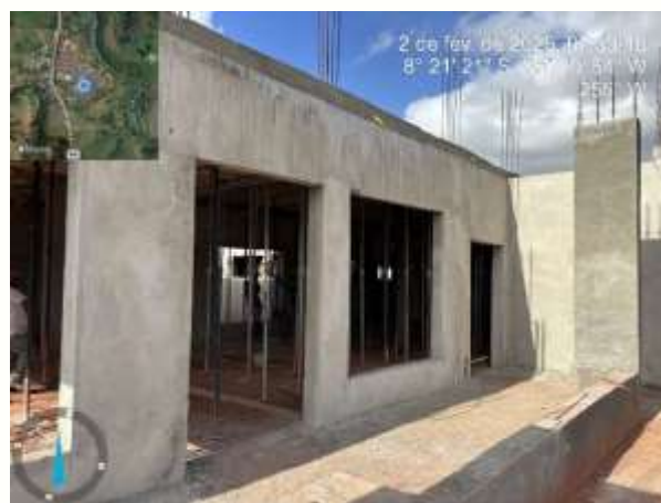
FOTO 7: Reboco externo executado;
