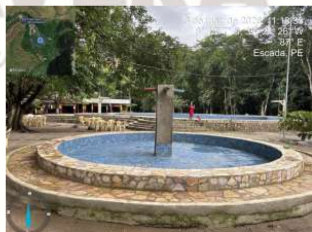
FOTO 6: REVESTO CERÂMICO EXECUTADO;
