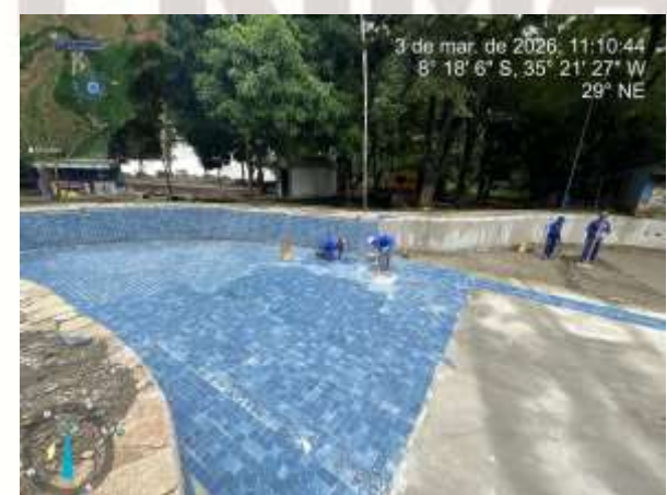
FOTO 5: REVESTO CERÂMICO EXECUTADO;
