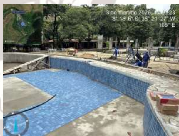
FOTO 4: REVESTO CERÂMICO EXECUTADO;
