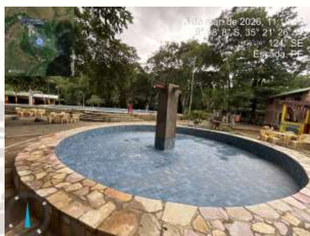
FOTO 2: REVESTO CERÂMICO EXECUTADO;
