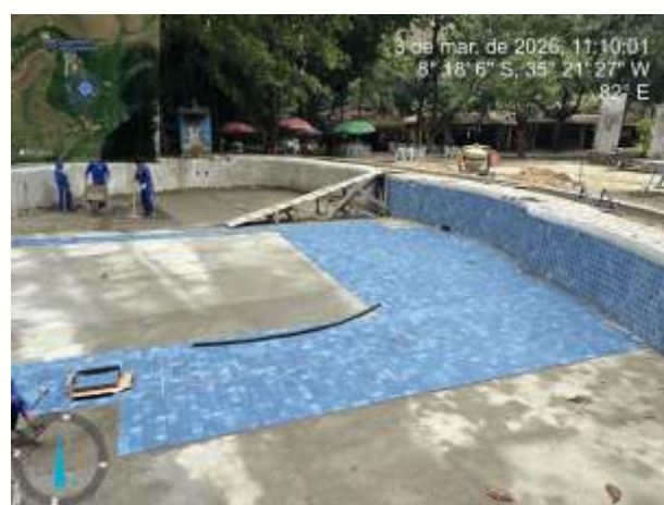
FOTO 1: REVESTO CERÂMICO EXECUTADO;
