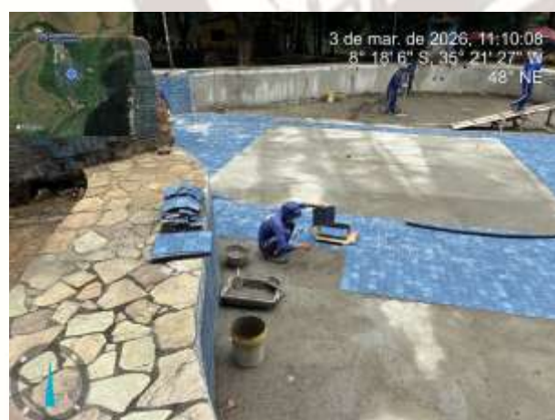
FOTO 3: REVESTO CERÂMICO EXECUTADO;
