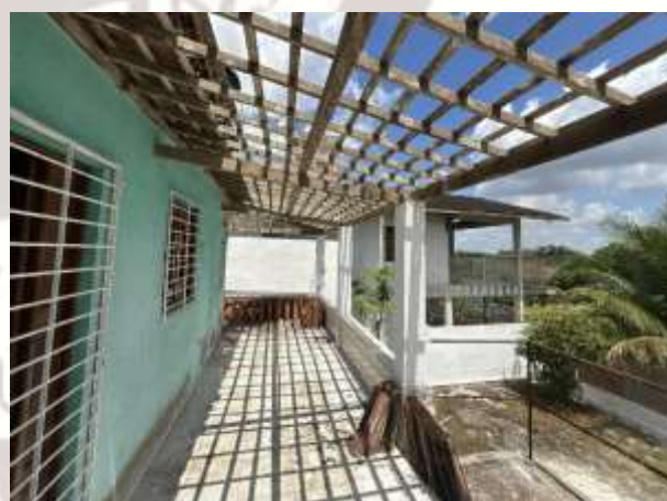
FOTO 4: RETIRADA DAS TELHAS;
