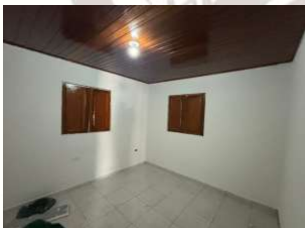
FOTO 09: PINTURA DO FORRO;
