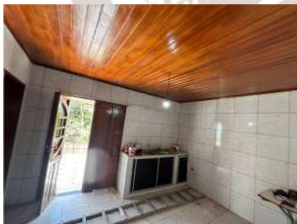
FOTO 3: PINTUR DO FORRO;
