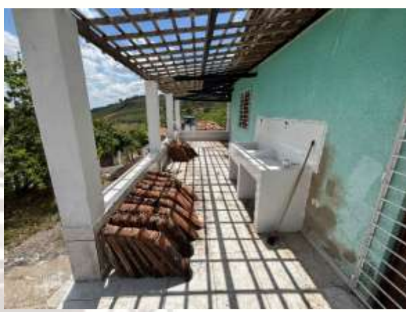
FOTO 8: RETIRADA DAS TELHAS;
