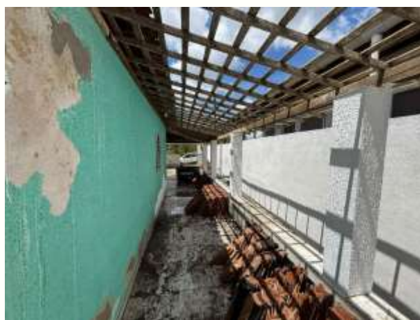
FOTO 1: RETIRADA DAS TELHAS;
