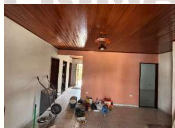
FOTO 5: PINTURA DA PAREDE;
