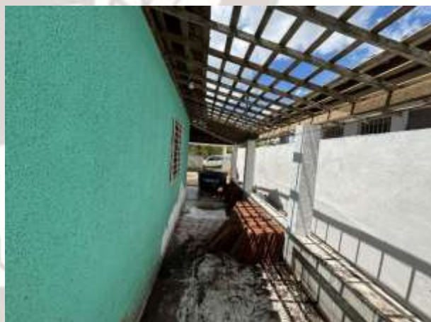
FOTO 10: RETIRADA DAS TELHAS;
