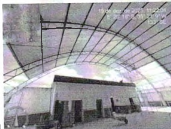
FOTO 3: ESTRUTURA METÁLICA EXECUTADA;
