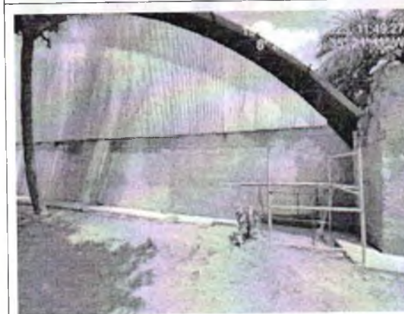
FOTO 11: CALHA DE ALVENARIA EXECUTADA;
