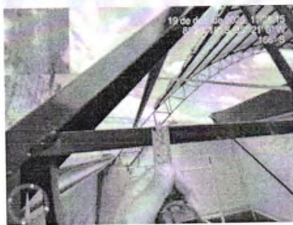
FOTO 5: ESTRUTURA METÁLICA EXECUTADA;
