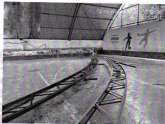
FOTO 8: TESOURA MONTADA;
