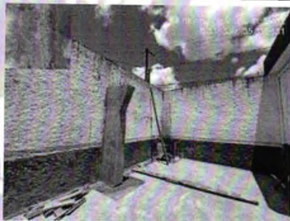
FOTO 10: PILAR CONCRETADO;
