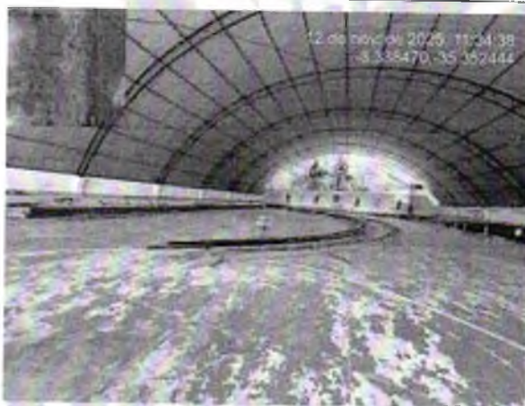
FOTO 09: TESOURA MONTADA;
