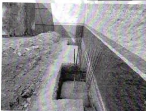
FOTO 3: CONCRETAGEM DA SAPATA;
