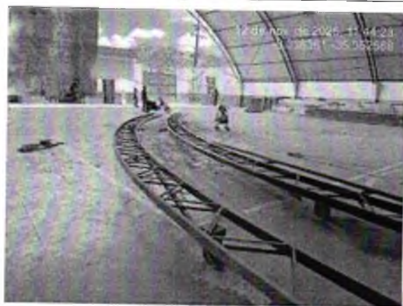
FOTO 7: TESOURA MONTADA;
