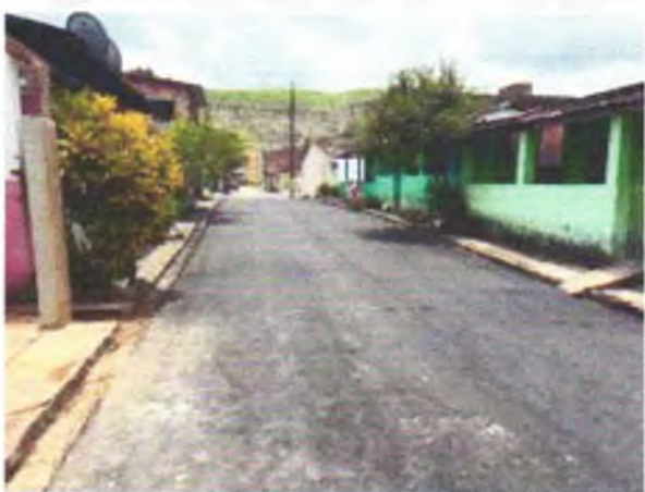
FOTO 11: PAVIMENTAÇÃO ASFÁLTICA EXECUTADA;
