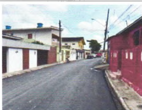
FOTO 1: PAVIMENTAÇÃO ASFÁLTICA EXECUTADA;
