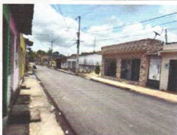
FOTO 10: PAVIMENTAÇÃO ASFÁLTICA EXECUTADA;
