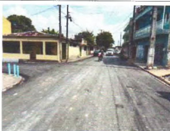
FOTO 7: PAVIMENTAÇÃO ASFÁLTICA EXECUTADA;
