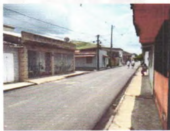
FOTO 6: PAVIMENTAÇÃO ASFÁLTICA EXECUTADA;
