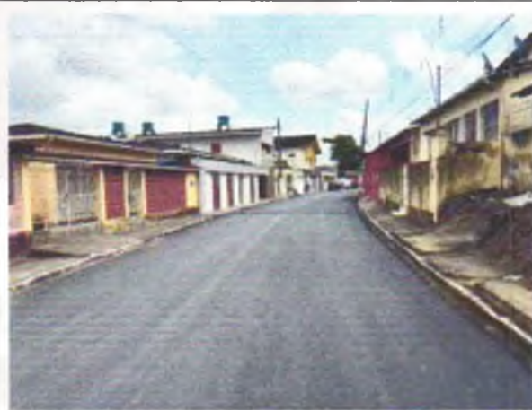
FOTO 4: PAVIMENTAÇÃO ASFÁLTICA EXECUTADA;
