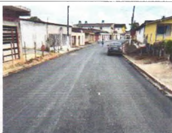
FOTO 2: PAVIMENTAÇÃO ASFÁLTICA EXECUTADA;
