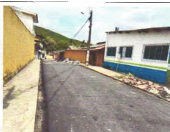
FOTO 8: PAVIMENTAÇÃO ASFÁLTICA EXECUTADA;
