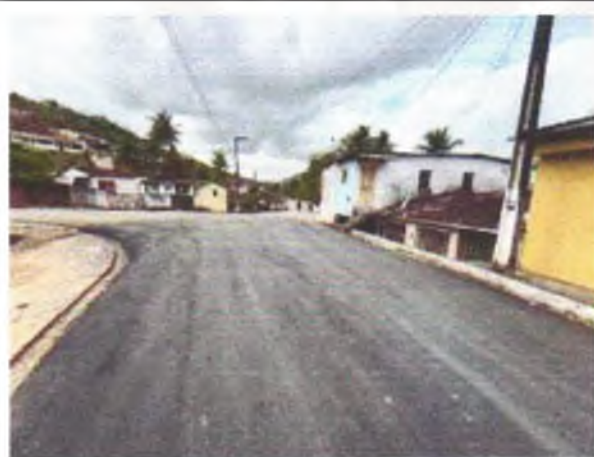
FOTO 3: PAVIMENTAÇÃO ASFÁLTICA EXECUTADA;
