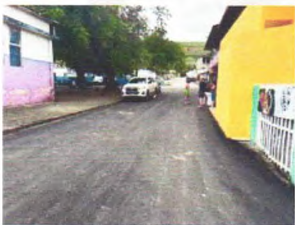
FOTO 09: PAVIMENTAÇÃO ASFÁLTICA EXECUTADA;
