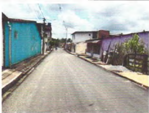
FOTO 12: PAVIMENTAÇÃO ASFÁLTICA EXECUTADA;
