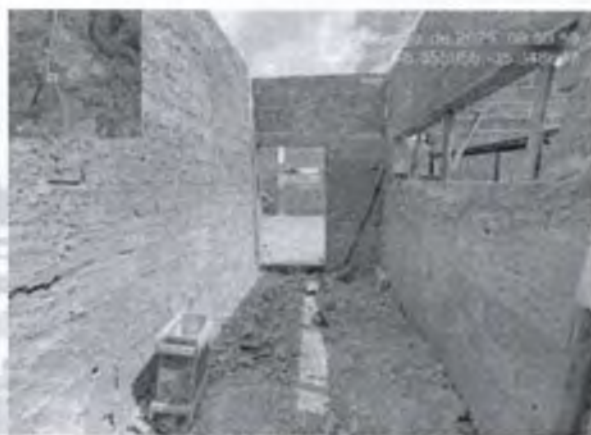
FOTO 8: Chapisco em paredes;
