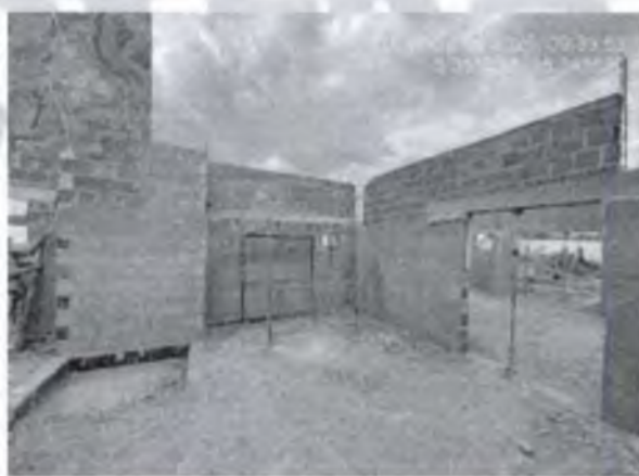
FOTO 6: Vergas e contravergas;
