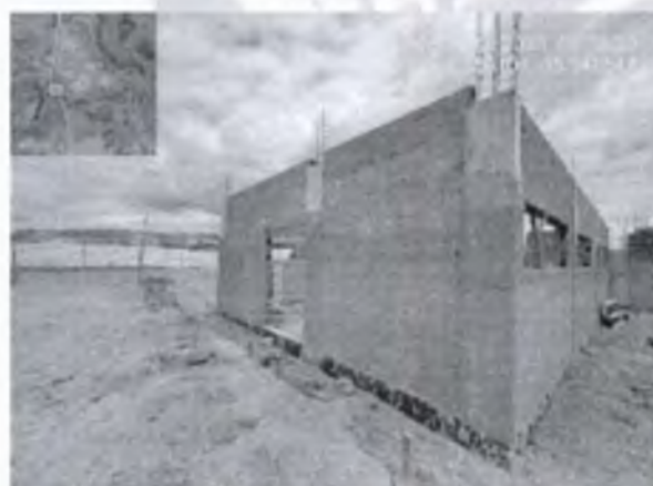
FOTO 09: Chapisco em paredes;
