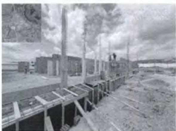
FOTO 1: Forma de viga baldrame;
