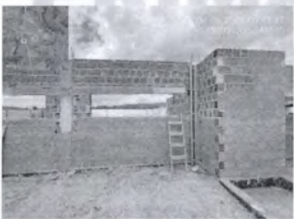
FOTO 5: Vergas e contravergas;
