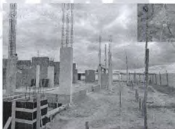
FOTO 12: Forma, aço E concreto
