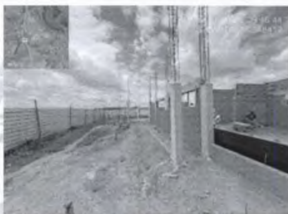
FOTO 2: Vista da fachada;
