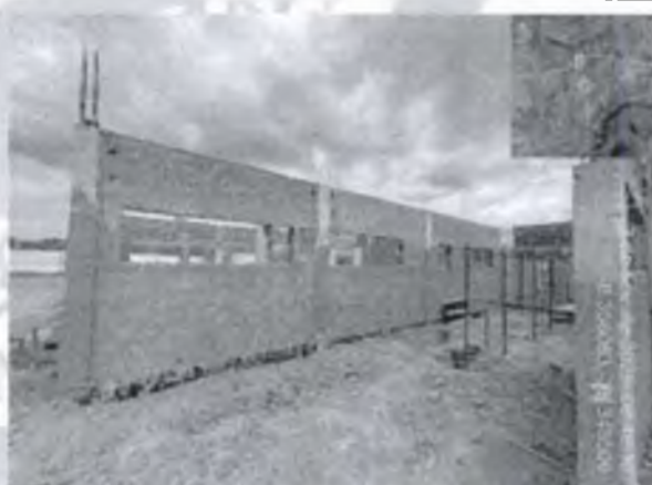
FOTO 4: Alvenaria e chapisco;
