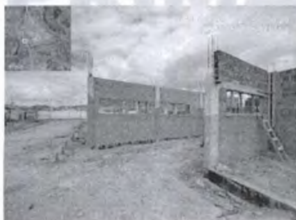
FOTO 11: Alvenaria, chapisco e pilares
