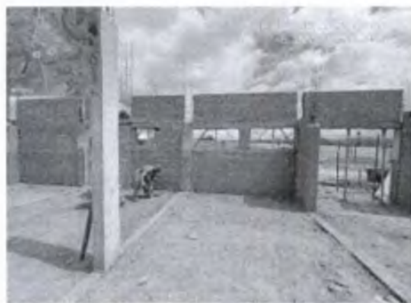
FOTO 7: Chapisco em paredes;
