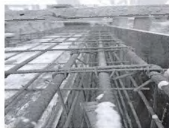
FOTO 3: Armadura de viga;
