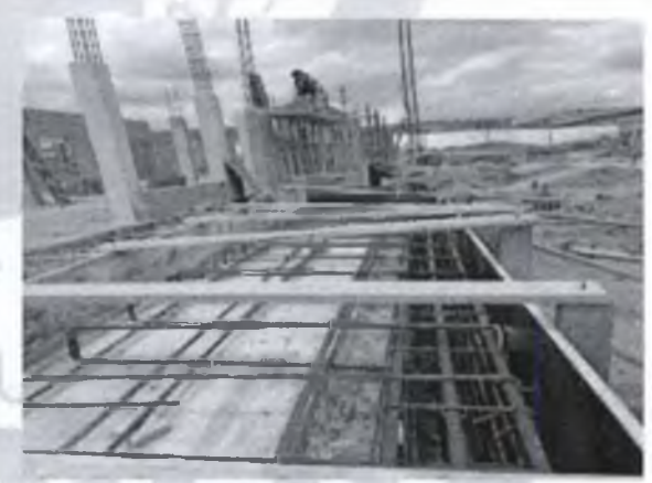
FOTO 10: Forma e aço de viga baldrame
