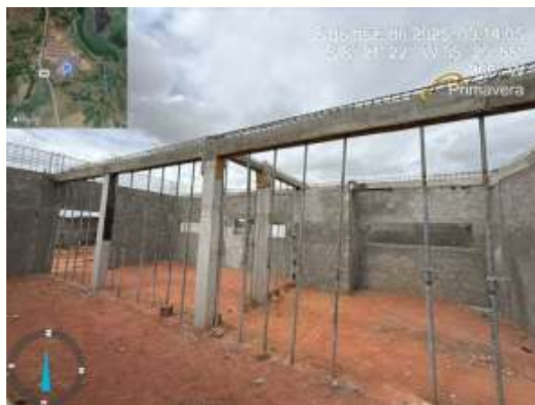
FOTO 7: Vigas de concreto
