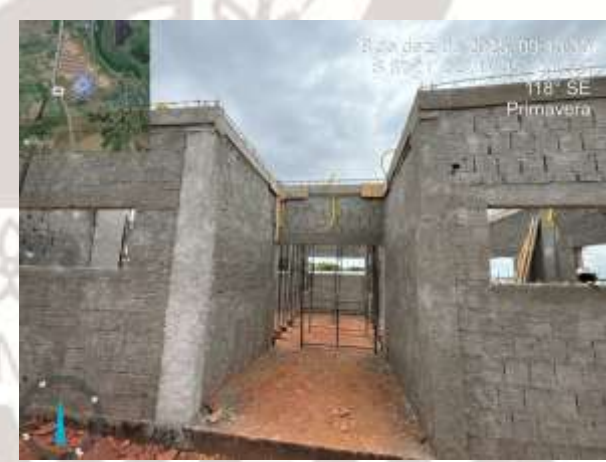
FOTO 4: Alvenaria e chapisco
