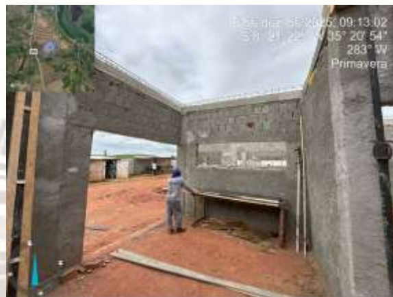
FOTO 8: Vigas de concreto
