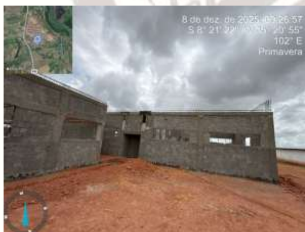
FOTO 09: Vista de alvenaria com chapisco
