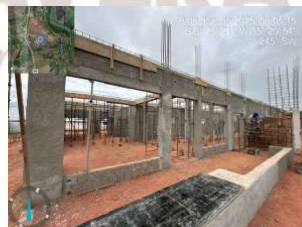
FOTO 6: Forma de viga
