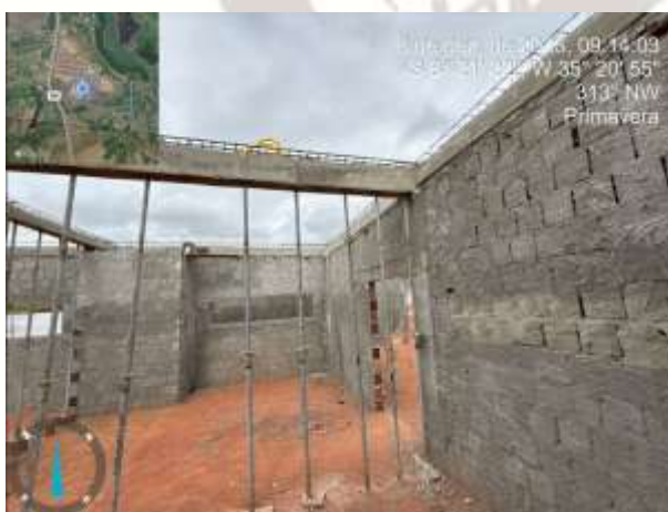
FOTO 3: Alvenaria e chapisco
