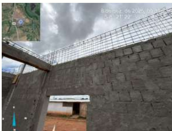
FOTO 1: Armação de vigas de cobertura
