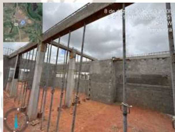
FOTO 10: Escoramento de vigas de cobertura
