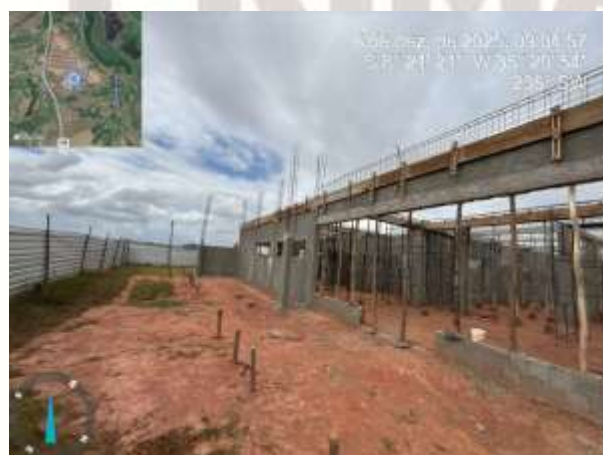
FOTO 5: Forma de viga
