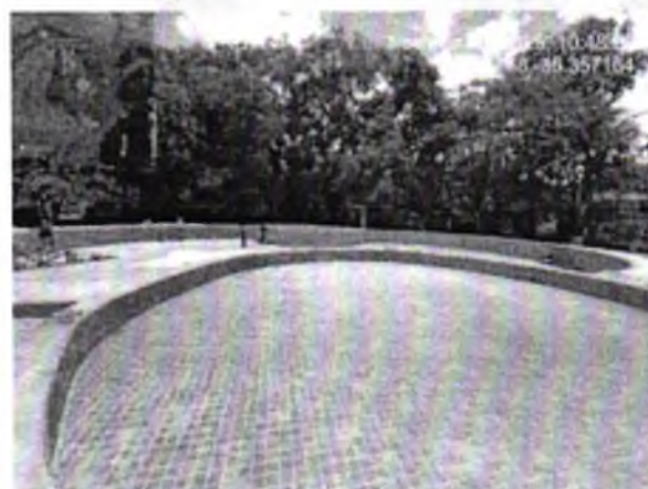
FOTO 3: REVESTO CERÂMICO EXECUTADO;
