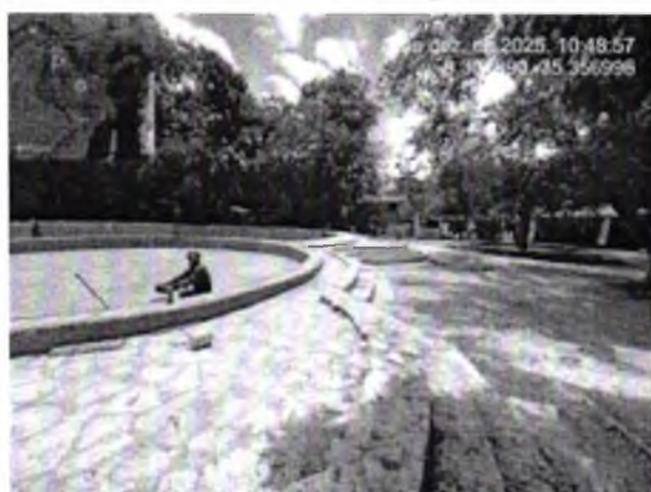
FOTO 1: REVESTO CERÂMICO EXECUTADO;
