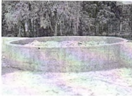
FOTO 7: REBOCO FINALIZADO EM PAREDES;
