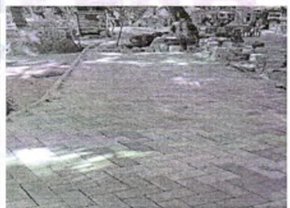
FOTO 12: APLICAÇÃO DE INTERTRAVADO;
