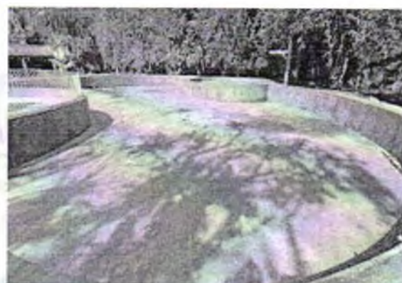
FOTO 2: PISCINA VAZIA PARA DEMOLIÇÃO;
