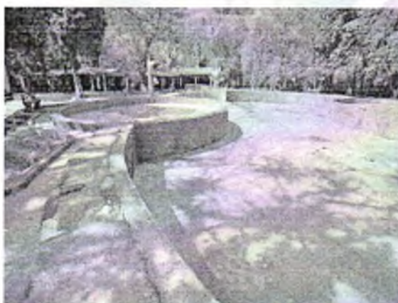
FOTO 3: PISCINA VAZIA PARA DEMOLIÇÃO;
