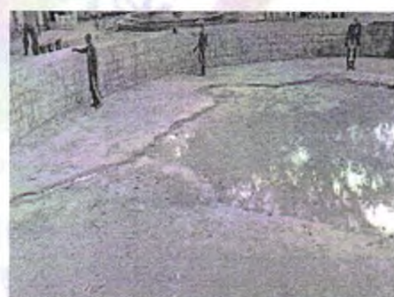
FOTO 4: DEMOLIÇÃO DE PISO E PAREDE;
