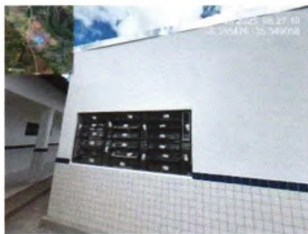
FOTO 7: REVESTIMENTO CERÂMICO EXECUTADO;
