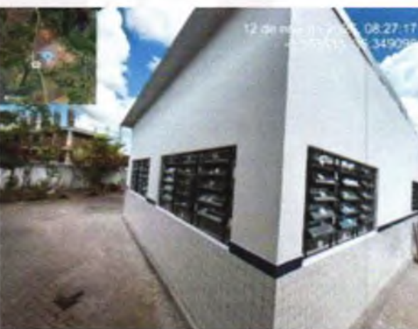
FOTO 10: REVESTIMENTO CERÂMICO EXECUTADO;
