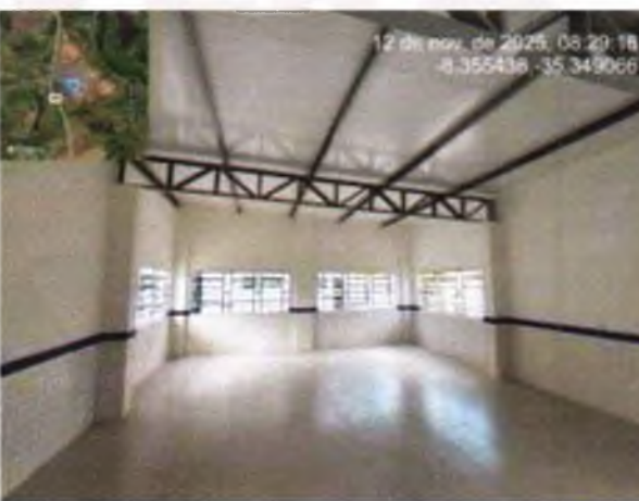
FOTO 12: REVESTIMENTO CERÂMICO EXECUTADO;
