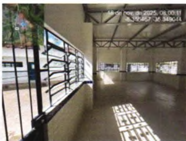
FOTO 2: REVESTIMENTO CERÂMICO EXECUTADO;
