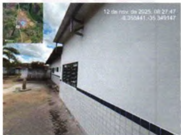
FOTO 6: REVESTIMENTO CERÂMICO EXECUTADO;
