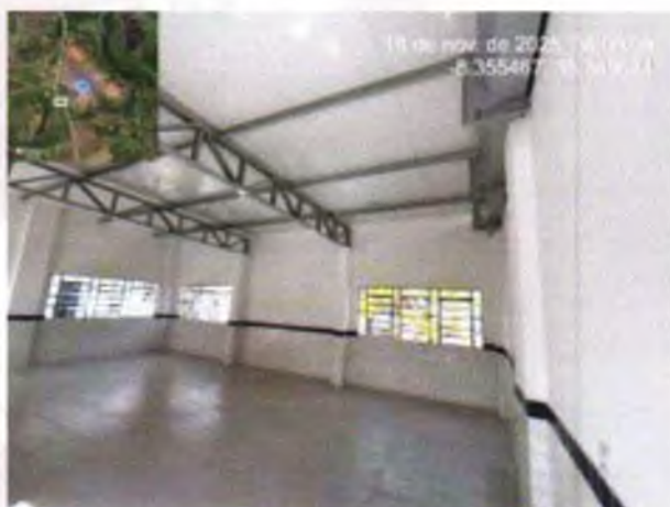
FOTO 4: ESTRUTURA METÁLICA INSTALADA;
