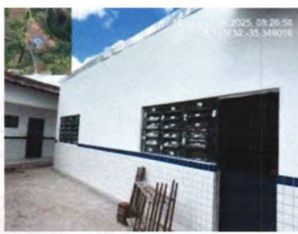
FOTO 8: REVESTIMENTO CERÂMICO EXECUTADO;
