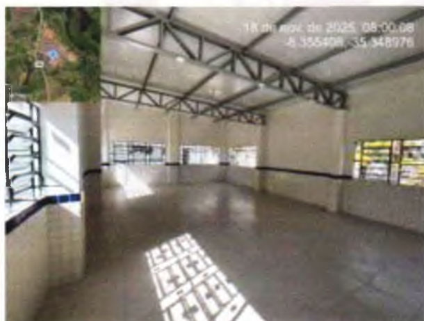
FOTO 3: REVESTIMENTO CERÂMICO EXECUTADO;
