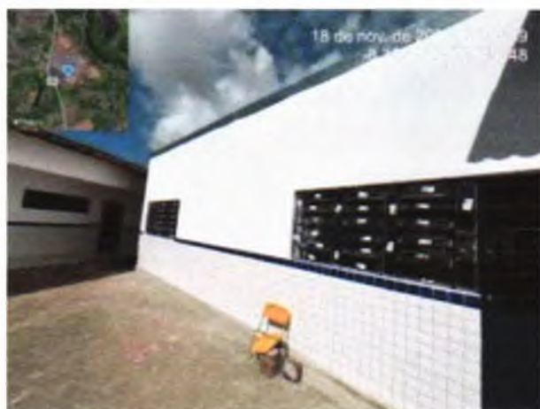
FOTO 1: REVESTIMENTO CERÂMICO EXECUTADO;
