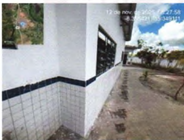
FOTO 09: REVESTIMENTO CERÂMICO EXECUTADO;
