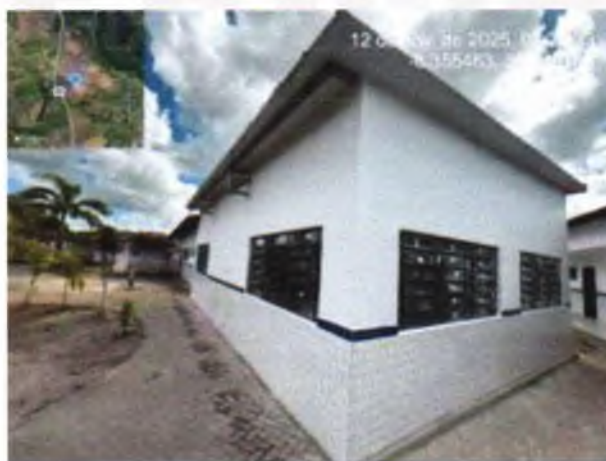
FOTO 11: REVESTIMENTO CERÂMICO EXECUTADO;
