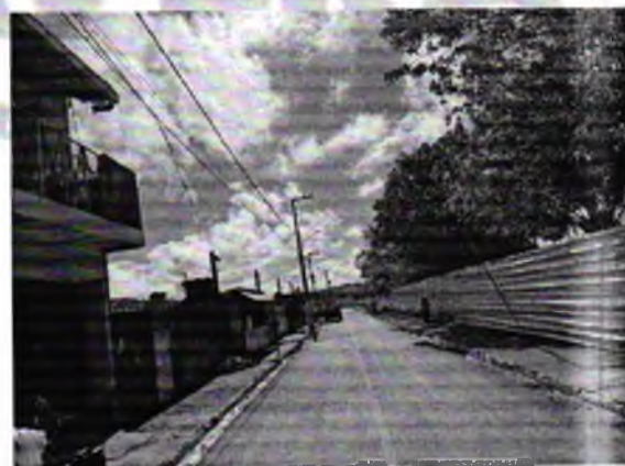
FOTO 12: SINALIZAÇÃO RESIDENCIAL PRIMAVERA;
