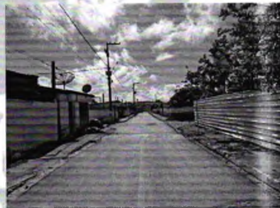
FOTO 10: SINALIZAÇÃO RESIDENCIAL PRIMAVERA;
