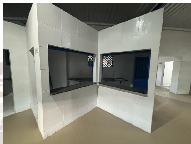
FOTO 8: Bancada em granito instalada;
