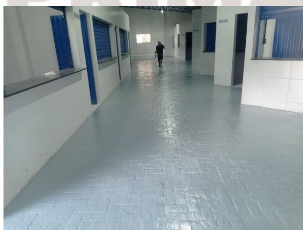
FOTO 11: Pintura epóxi executada;
