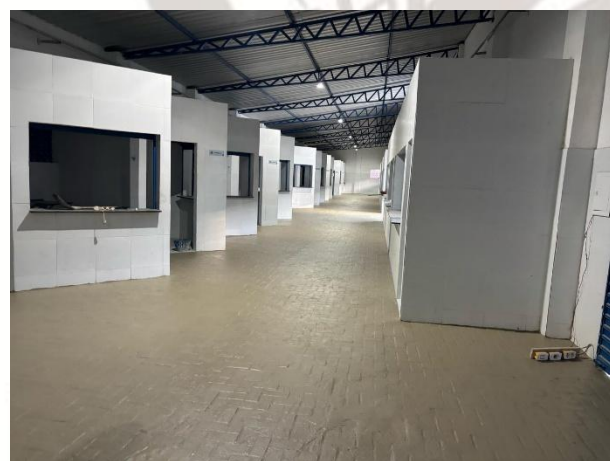
FOTO 3: Bancada em granito instalada;
