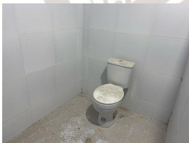
FOTO 09: Vaso sanitário instalado;
