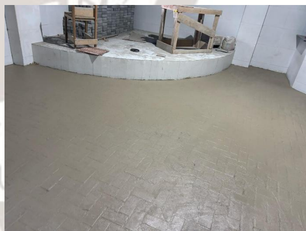
FOTO 4: Revestimento cerâmico executado;
