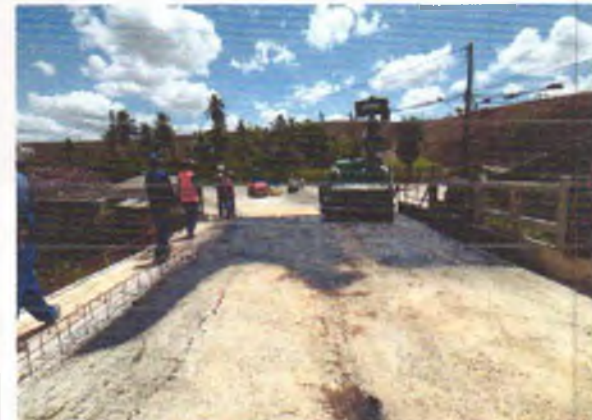
FOTO 4: IMPRIMAÇÃO E PINTURA NA PONTE;
