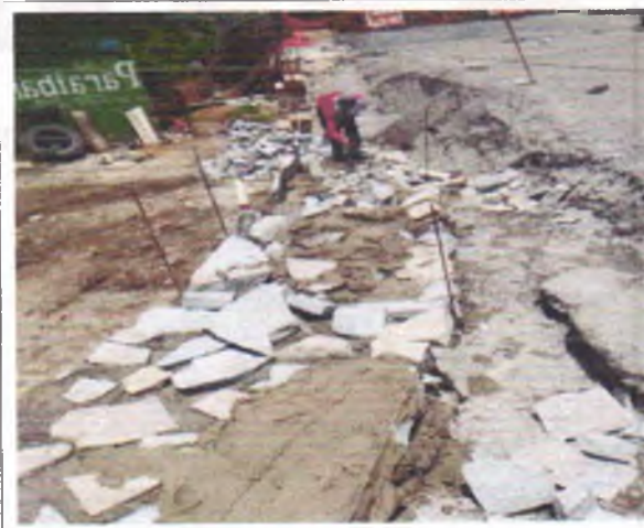
FOTO 12: COMPLEMENTO DO MURO.
