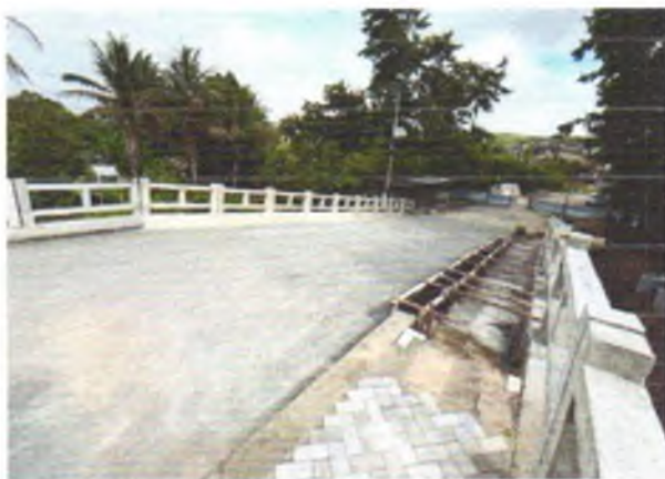
FOTO 7: APLICATION DE PAVER NO PASSEIO;
