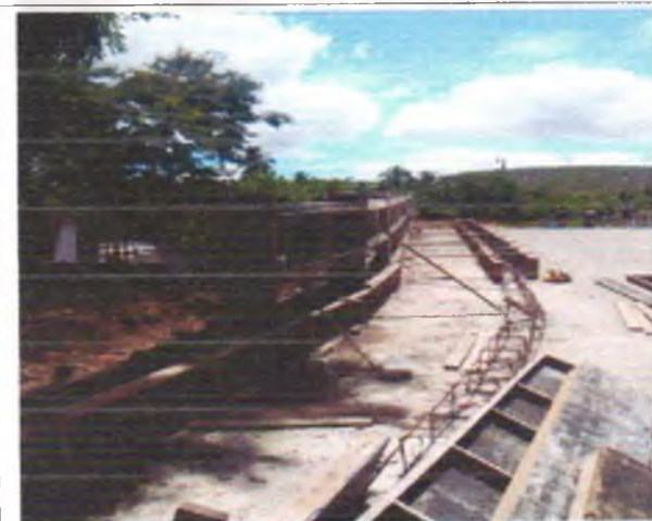
FOTO 11: PASSEIO 2º ENCONTRO SENDO EXECUTADO E FINALIZAÇÃO DA LAJE DE PASSE
