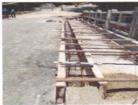
FOTO 10: VIGA DE MEIO FIO NA PONTE;
