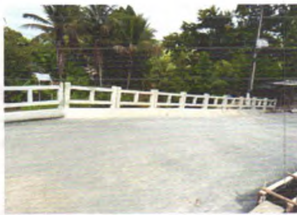
FOTO 8: APLICATION DE GUARDA CORPO;
