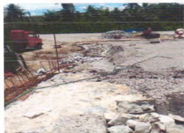
FOTO 09: COMPLEMENTO DE MURO;
