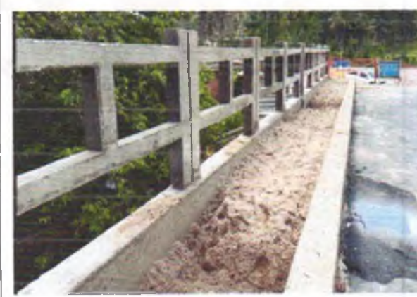
FOTO 6: ATERRO PARA APLICAÇÃO DE PAVER;
