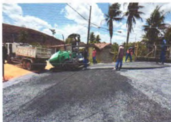
FOTO 5: ASFALTO NO 1º ENCONTRO;
