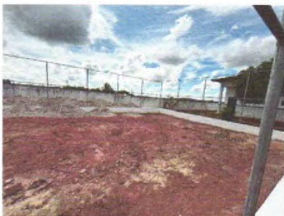
FOTO 7: AREIA DE ATERRO PARA SER EXECUTADO;
