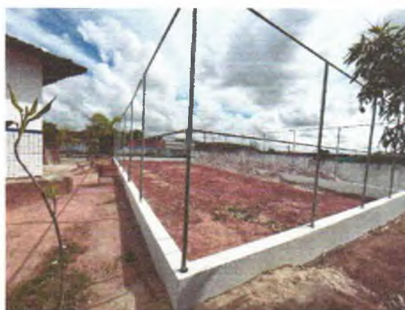
FOTO 10: ESTRUTURA DO ALAMBRADO E MURETA EM ALVENARIA EXECUTADOS;
