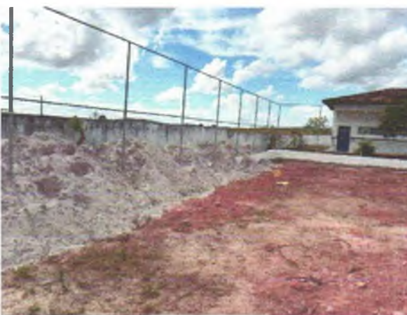
FOTO 09: AREIA DE ATERRO PARA SER EXECUTADO;
