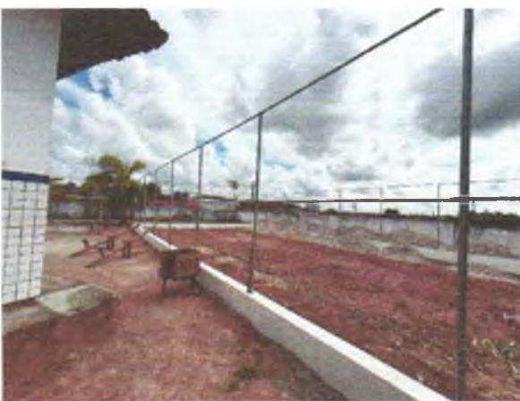
FOTO 11: ESTRUTURA DO ALAMBRADO E MURETA EM ALVENARIA EXECUTADOS;
