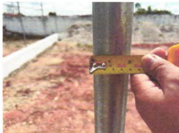
FOTO 2: TUBO DO ALAMBRADO EXECUTADO;
