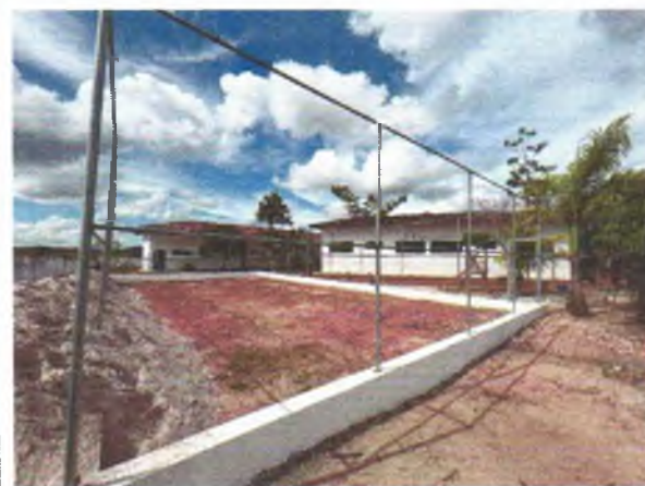
FOTO 6: AREIA DE ATERRO PARA SER EXECUTADO;
