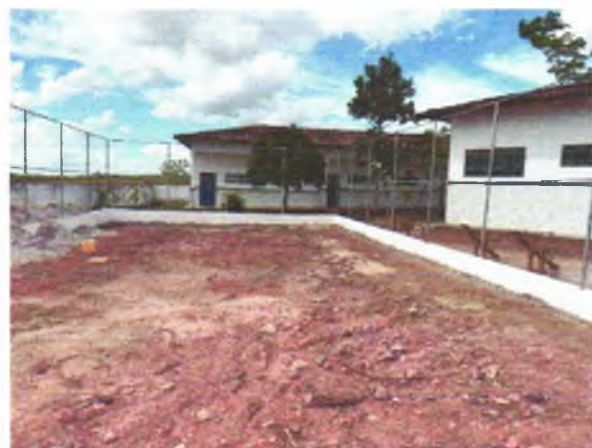
FOTO 4: ESTRUTURA DO ALAMBRADO E MURETA EM ALVENARIA EXECUTADOS;
