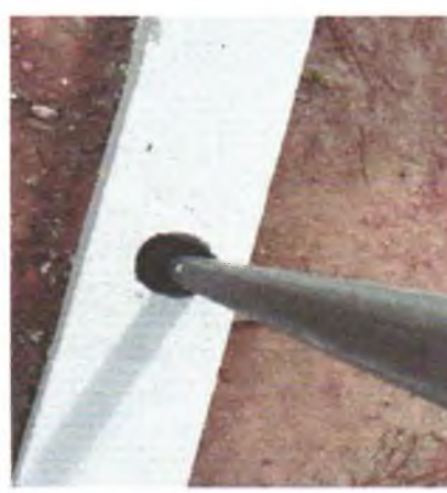
FOTO 12: ESTRUTURA DO ALAMBRADO A SER CHUMBADA NA BASE;
