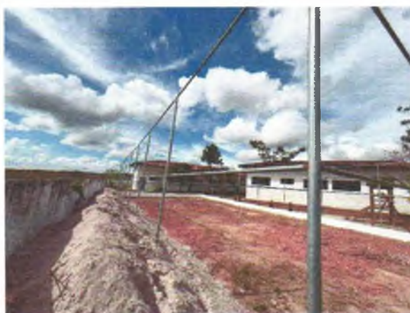
FOTO 5: AREIA DE ATERRO PARA SER EXECUTADO;
