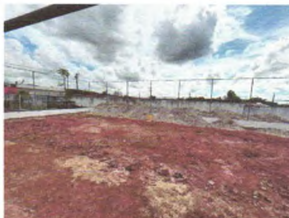
FOTO 8: AREIA DE ATERRO PARA SER EXECUTADO;
