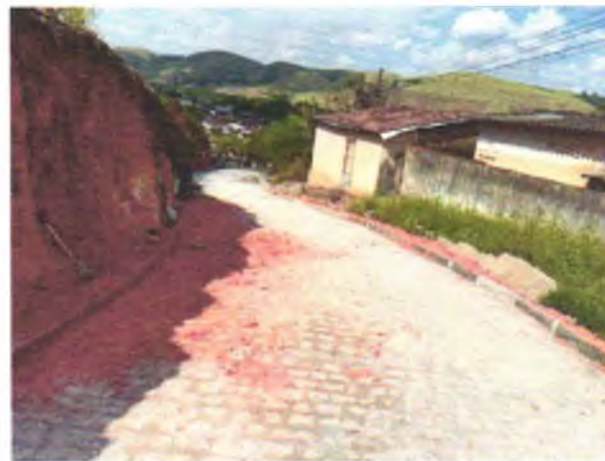
FOTO 10: PAVIMENTAÇÃO EM PARALELEPÍPEDOS GRANÍTICOS EXECUTADA;
