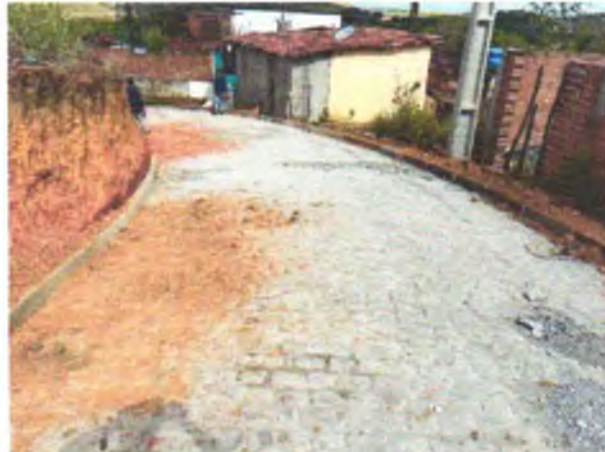
FOTO 8: PAVIMENTAÇÃO EM PARALELEPÍPEDOS GRANÍTICOS EXECUTADA;
