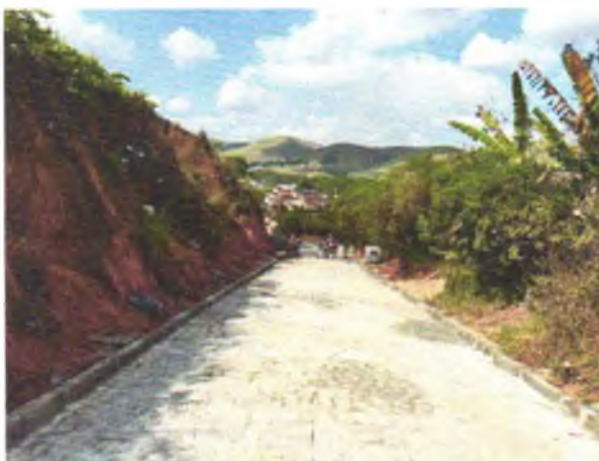
FOTO 09: PAVIMENTAÇÃO EM PARALELEPÍPEDOS GRANÍTICOS EXECUTADA;
