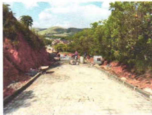
FOTO 6: PAVIMENTAÇÃO EM PARALELEPÍPEDOS GRANÍTICOS EXECUTADA;
