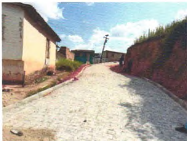
FOTO 7: PAVIMENTAÇÃO EM PARALELEPÍPEDOS GRANÍTICOS EXECUTADA;
