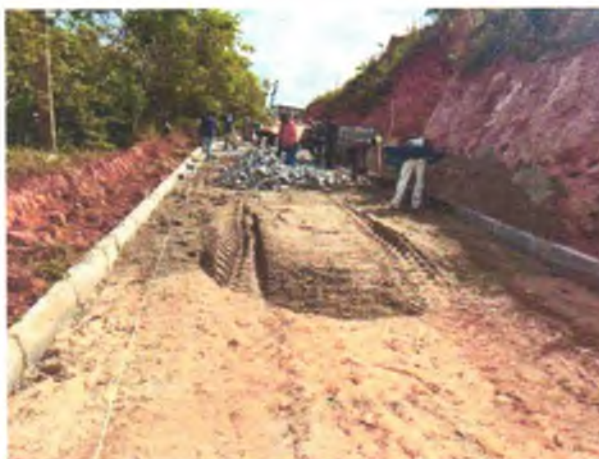
FOTO 5: PAVIMENTAÇÃO EM PARALELEPÍPEDOS GRANÍTICOS EM EXECUÇÃO;
