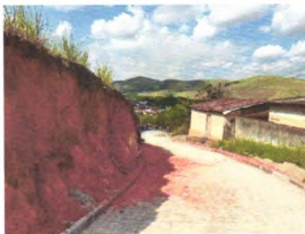
FOTO 11: PAVIMENTAÇÃO EM PARALELEPÍPEDOS GRANÍTICOS EXECUTADA;
