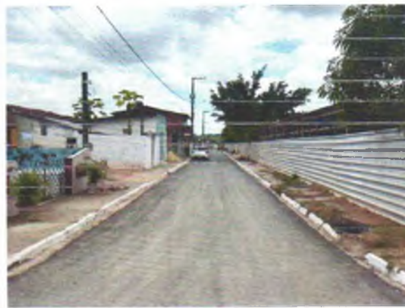
FOTO 10: RECAPEAMENTO ASFÁLTICO EXECUTADO;
