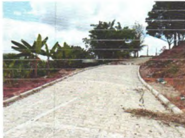
FOTO 2: PAVIMENTAÇÃO EM PARALELEPÍPEDO EXECUTADA;
