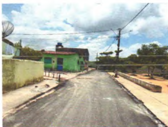
FOTO 5: RECAPEAMENTO ASFÁLTICO EXECUTADO;
