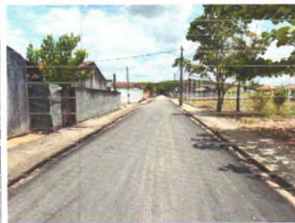
FOTO 6: RECAPEAMENTO ASFÁLTICO EXECUTADO;
