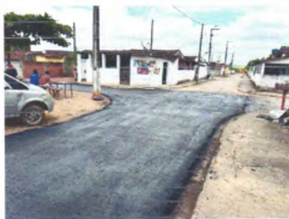
FOTO 11: RECAPEAMENTO ASFÁLTICO EXECUTADO;
