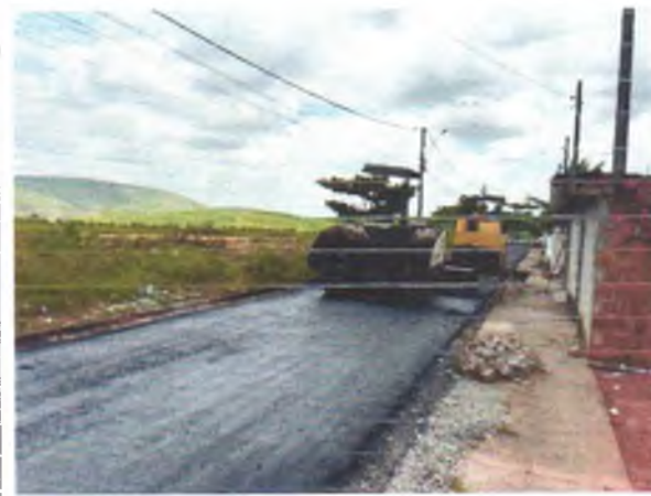
FOTO 12: RECAPEAMENTO ASFÁLTICO EXECUTADO;
