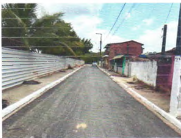
FOTO 09: RECAPEAMENTO ASFÁLTICO EXECUTADO;
