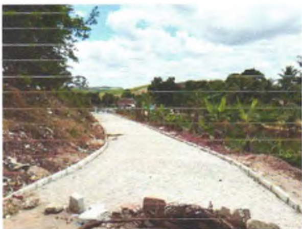
FOTO 3: PAVIMENTAÇÃO EM PARALELEPÍPEDO EXECUTADA;
