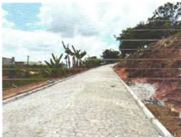
FOTO 1: PAVIMENTAÇÃO EM PARALELEPÍPEDO EXECUTADA;
