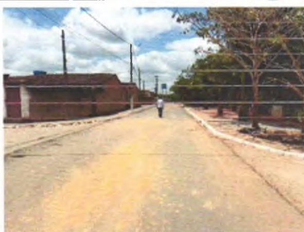
FOTO 8: RECAPEAMENTO ASFÁLTICO EXECUTADO;
