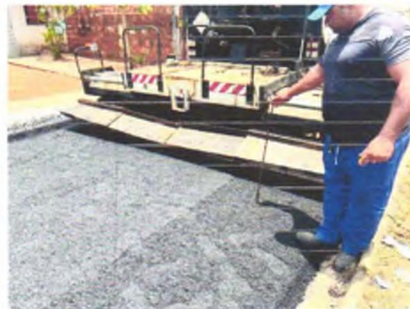
FOTO 4: RECAPEAMENTO ASFÁLTICO EXECUTADO;
