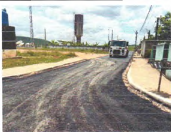
FOTO 7: RECAPEAMENTO ASFÁLTICO EXECUTADO;
