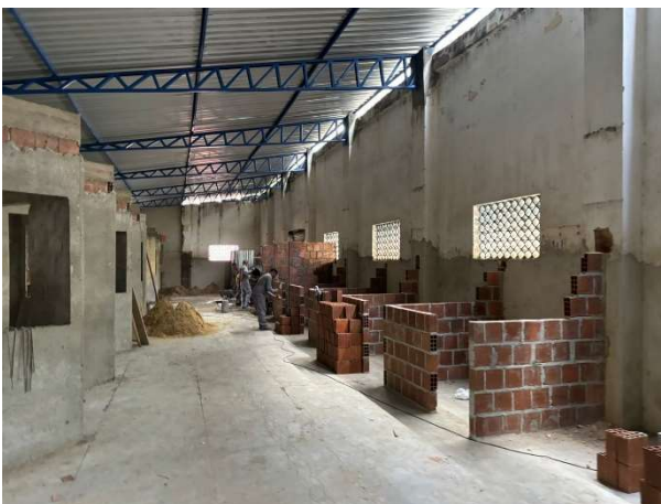
FOTO 3: EXECUÇÃO DE ALVENARIA;
