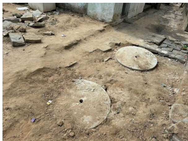
FOTO 10: FOSSA E FILTRO EXECUTADOS;
