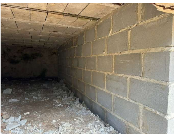
FOTO 11: EXECUÇÃO DE ALVENARIA DE REFORÇO;
