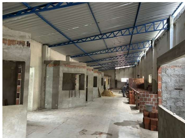
FOTO 4: EXECUÇÃO DE ALVENARIA;
