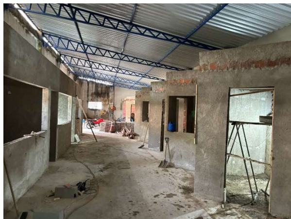
FOTO 7: EXECUÇÃO DE ALVENARIA;
