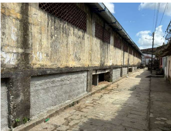
FOTO 09: EXECUÇÃO DE ALVENARIA DE REFORÇO;
