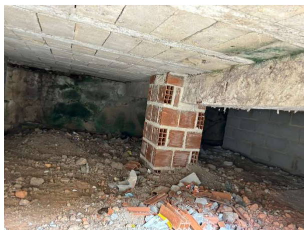
FOTO 12: EXECUÇÃO DE ALVENARIA DE FORMA PARA OS PILARETES DE REFORÇO;
