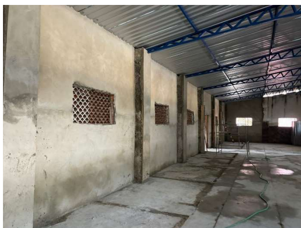
FOTO 11: REBOCO EXECUTADO;
