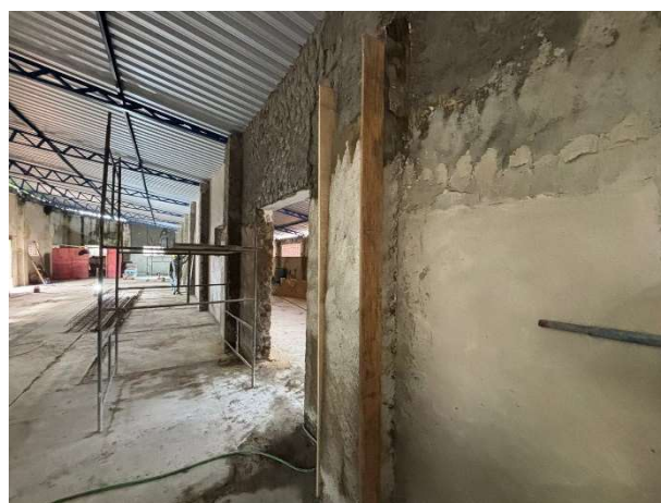
FOTO 6: REBOCO EXECUTADO;
