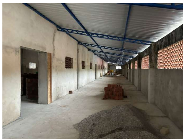
FOTO 12: REBOCO EXECUTADO;
