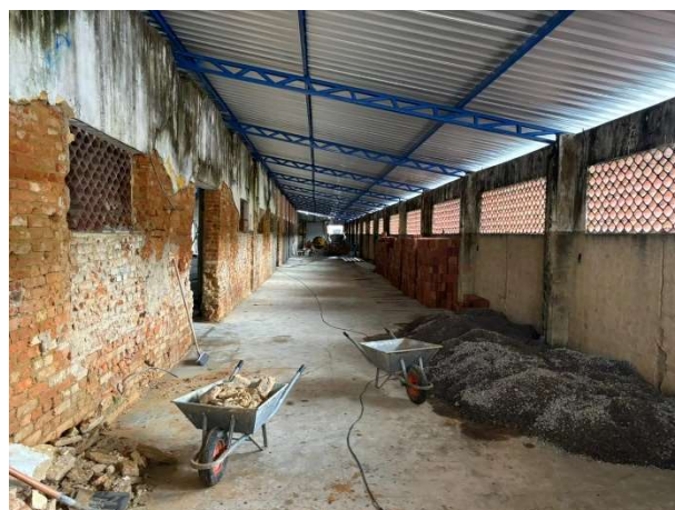
FOTO 4: DEMOLIÇÃO DE ARGAMASSA;
