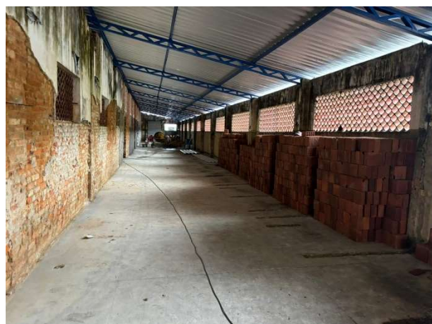
FOTO 3: DEMOLIÇÃO DE ARGAMASSA;
