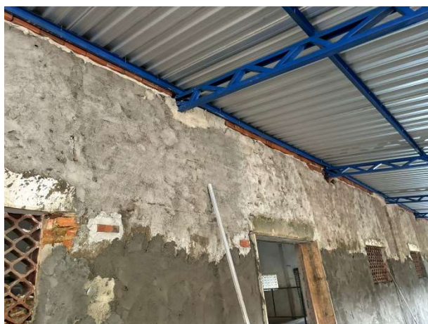
FOTO 09: EXECUÇÃO DE CHAPISCO;
