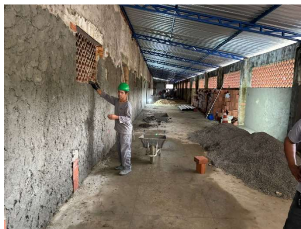
FOTO 10: EXECUÇÃO DE CHAPISCO;
