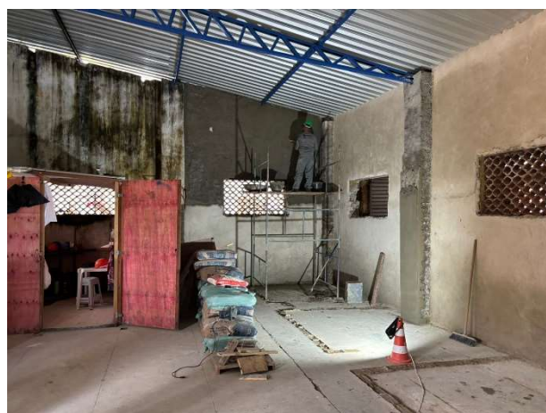
FOTO 5: REBOCO EXECUTADO;
