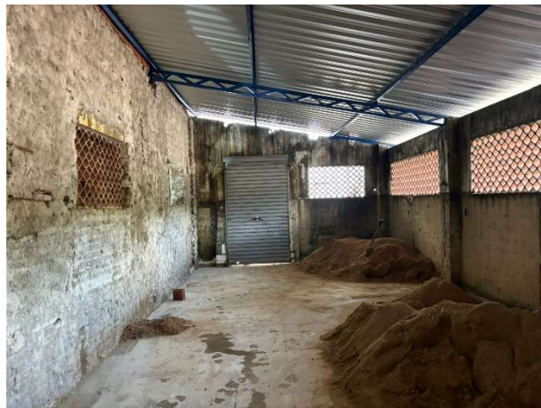
FOTO 7: DEMOLIÇÃO DE ARGAMASSA;
