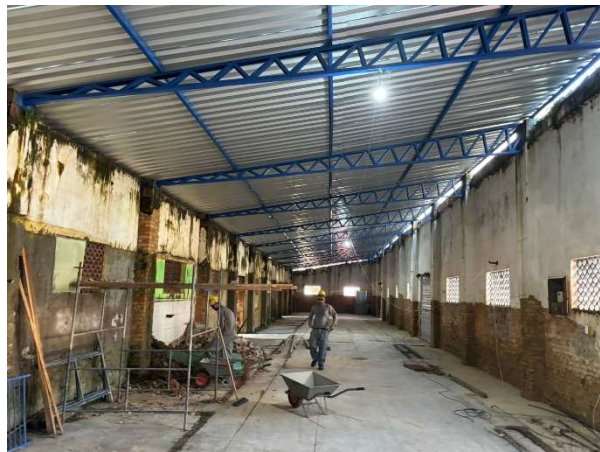
FOTO 7: ESTRUTURA METÁLICA PINTADA;
