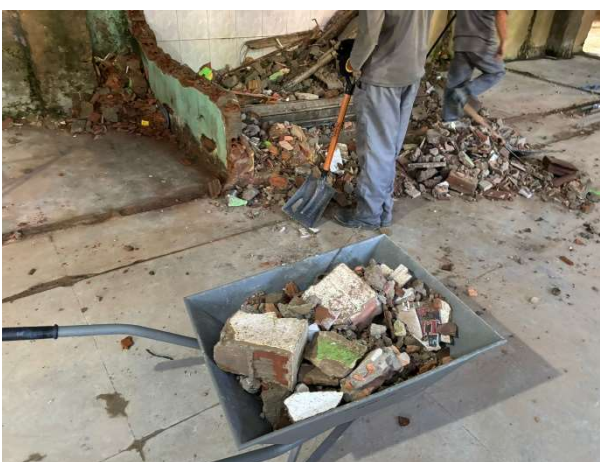
FOTO 11: DEMOLIÇÃO DE ARGAMASSA;
