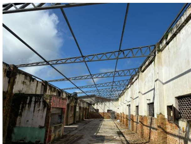
FOTO 3: PINTURA COM ZARCÃO DA ESTRUTURA;
