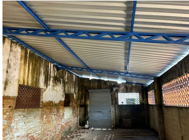
FOTO 8: TELHAMENTO EXECUTADO;
