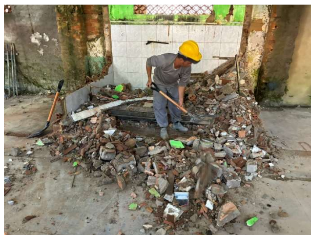
FOTO 10: DEMOLIÇÃO DE ARGAMASSA;
