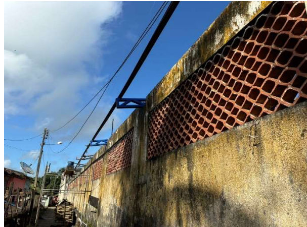
FOTO 2: PINTURA COM ZARCÃO DA ESTRUTURA;
