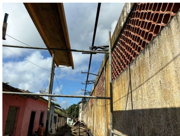
FOTO 4: PINTURA COM ZARCÃO DA ESTRUTURA;
