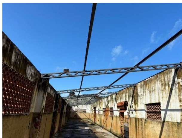
FOTO 5: PINTURA COM ZARCÃO DA ESTRUTURA;
