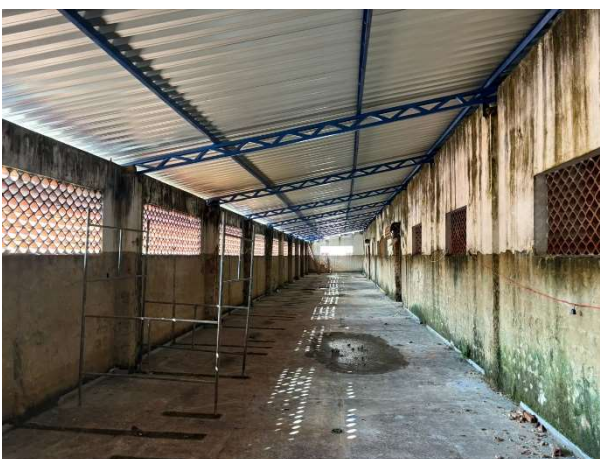
FOTO 09: TELHAMENTO EXECUTADO;
