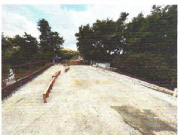
FOTO 12: TABULEIRO CONCRETADO;
