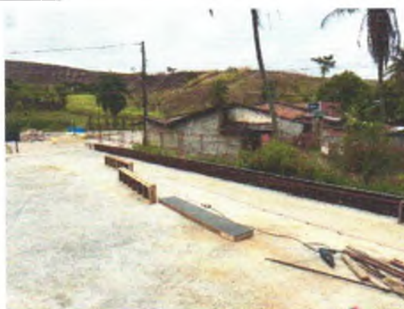
FOTO 5: TABULEIRO CONCRETADO;
