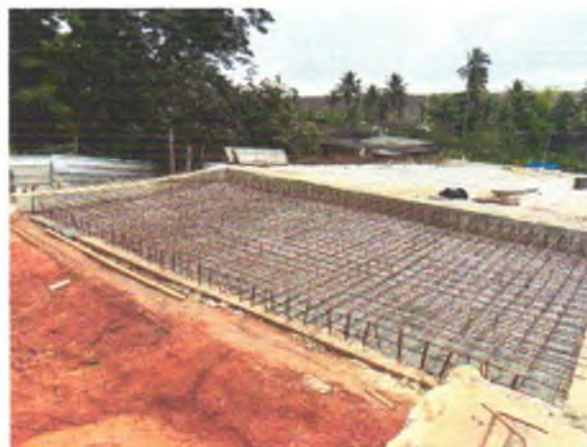
FOTO 4: ARMADURA DA LAJE DE TRANSIÇÃO EXECUTADA;
