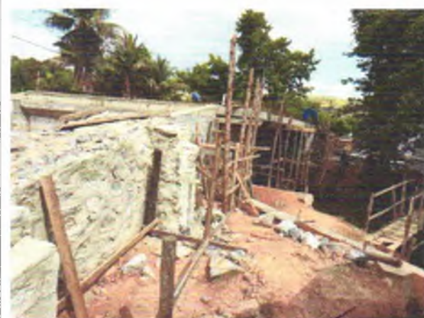
FOTO 11: MURO DE ARRIMO EXECUTADO;
