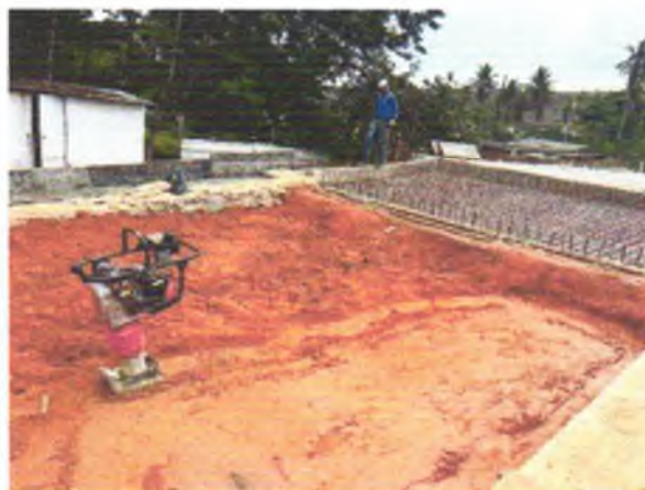
FOTO 2: ATERRO DO 2º ENCONTRO EXECUTADO;
