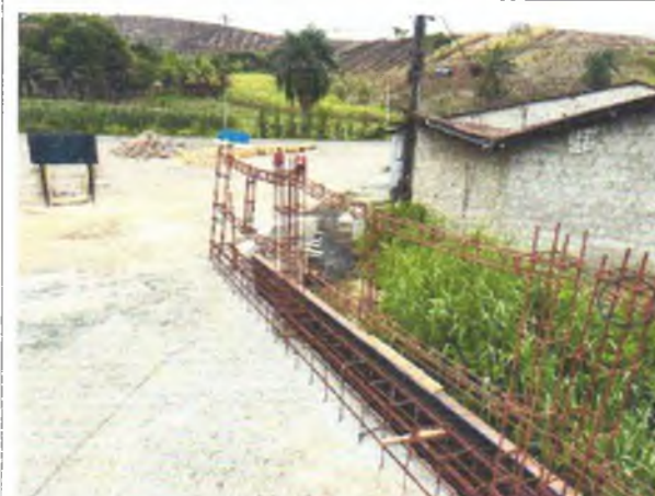
FOTO 09: ARMAÇÃO DA VIGA DE BORDO EXECUTADA;
