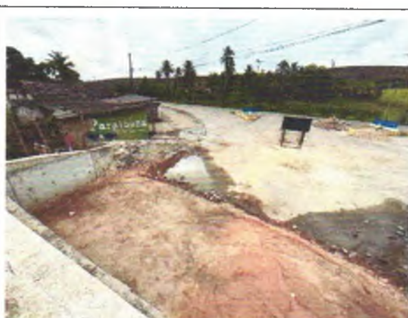
FOTO 8: MURO DE ARRIMO EXECUTADO;
