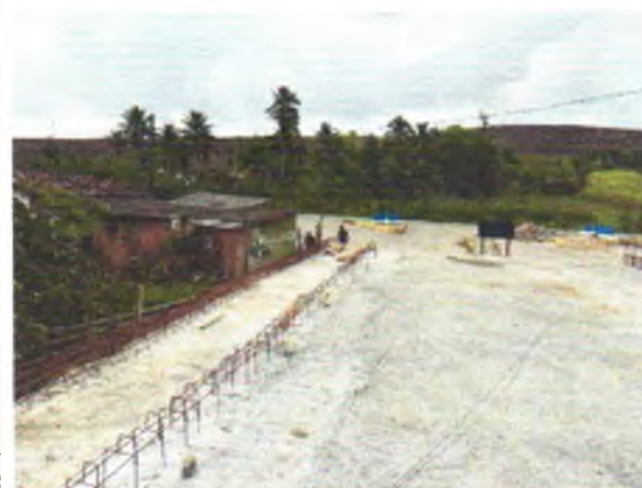
FOTO 6: TABULEIRO CONCRETADO;
