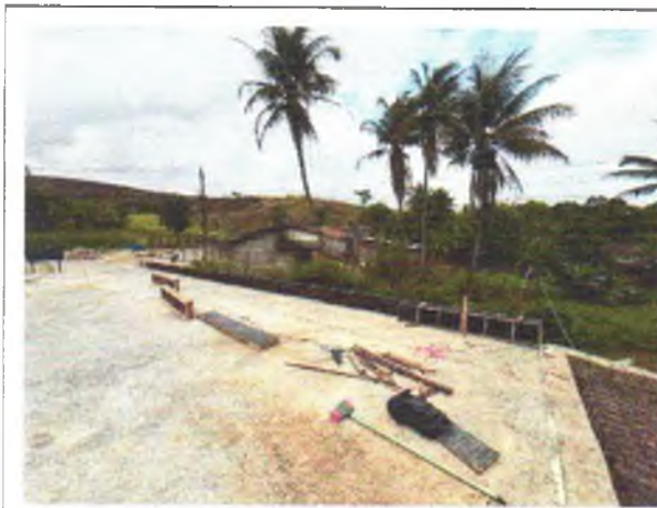
FOTO 7: TABULEIRO CONCRETADO;
