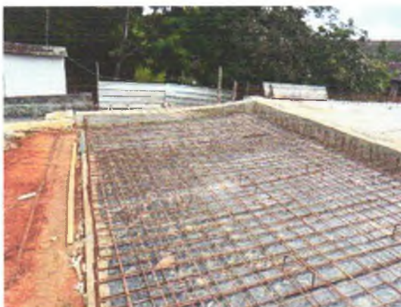
FOTO 3: ARMADURA DA LAJE DE TRANSIÇÃO EXECUTADA;
