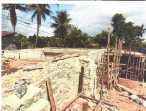
FOTO 10: MURO DE ARRIMO EXECUTADO;
