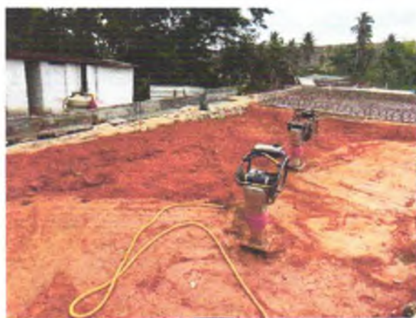
FOTO 1: ATERRO DO 2º ENCONTRO EXECUTADO;
