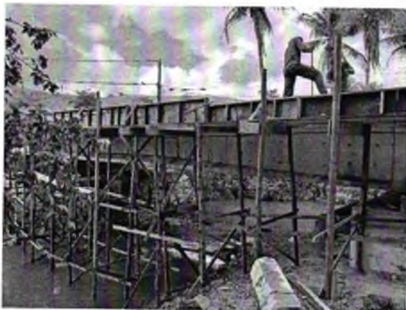
FOTO 5: FORMA DO TABULEITO EXECUTADA;
