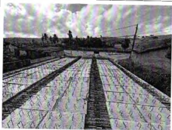
FOTO 2: PRÉ-LAJE INSTALADA;
