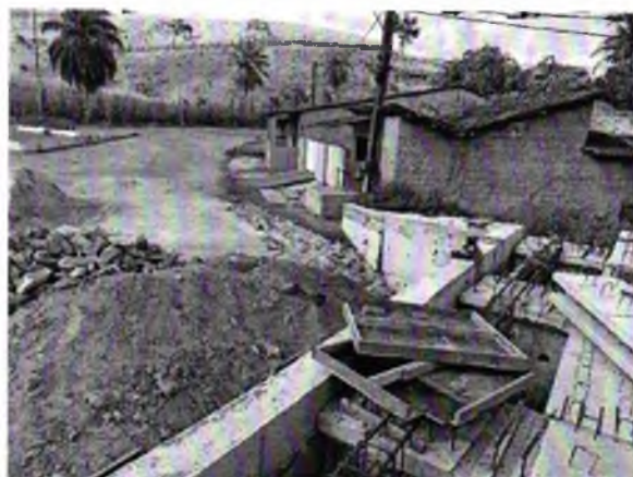
FOTO 8: ARMAÇÃO DA TRANSVERSINA;
