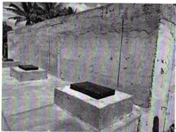
FOTO 6: NEOPRENE INSTALADO;
