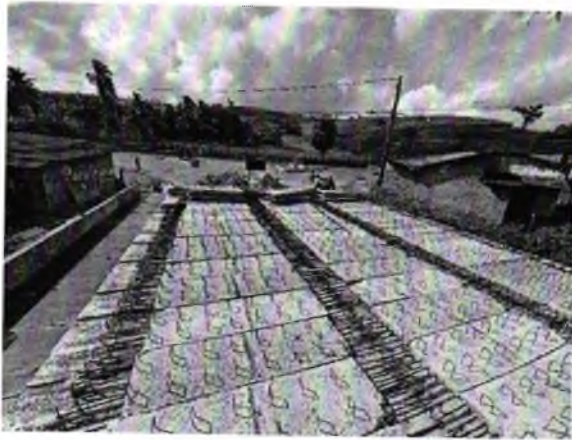
FOTO 1: PRÉ-LAJE INSTALADA;
