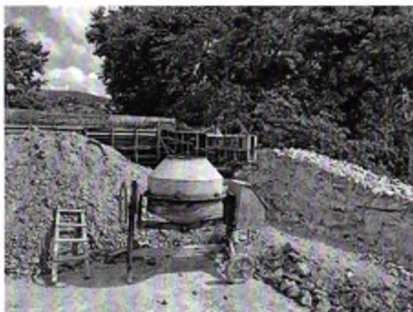
FOTO 11: MURO DE ARRIMO EM EXECUÇÃO;
