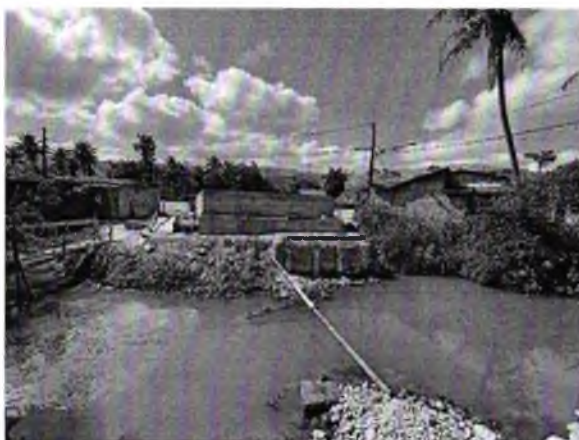
FOTO 09: BLOCOS E ALAS EXECUTADOS;
