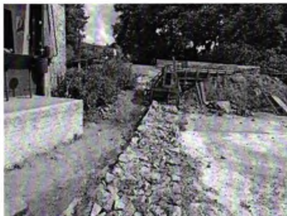
FOTO 12: MURO DE ARRIMO EM EXECUÇÃO;
