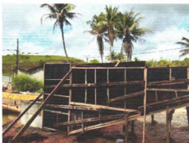
FOTO 6: FORMA DAS ALAS EXECUTADAS;
