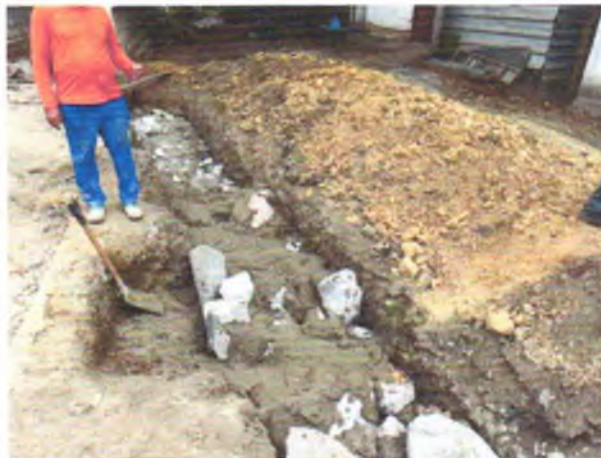
FOTO 8: MURO DE ARRIMO EM EXECUÇÃO;
