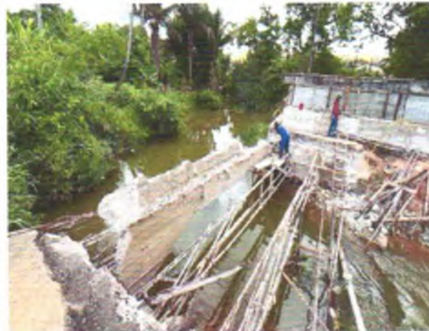
FOTO 10: PONTE EXISTENTE DEMOLIDADA;
