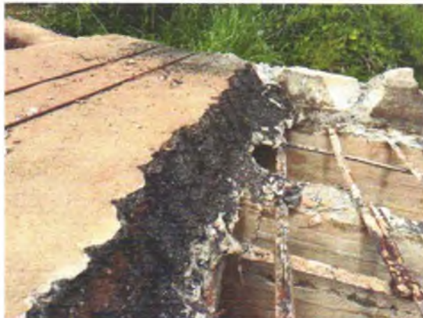
FOTO 2: DEMOLIÇÃO DA PONTE EXISTENTE;
