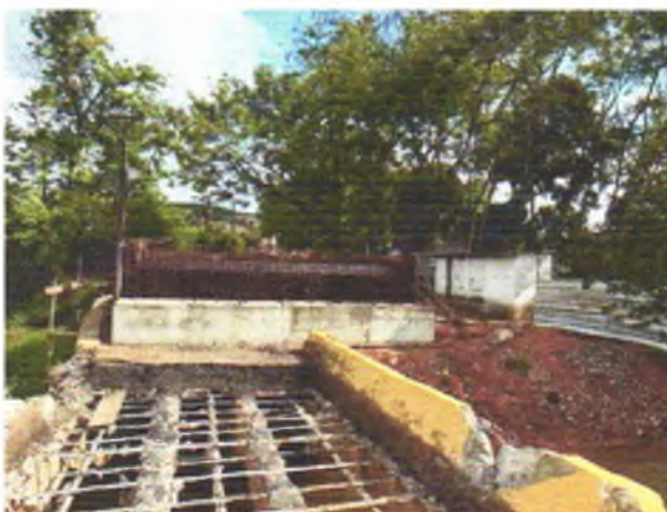
FOTO 3: DEMOLIÇÃO DA PONTE EXISTENTE;
