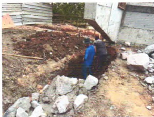
FOTO 7: MURO DE ARRIMO EM EXECUÇÃO;
