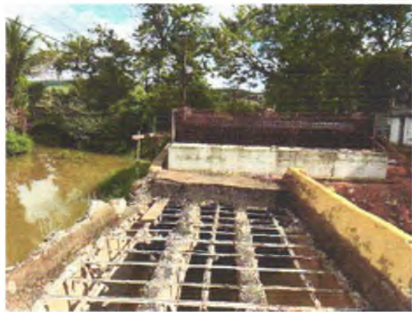
FOTO 1: DEMOLIÇÃO DA PONTE EXISTENTE;
