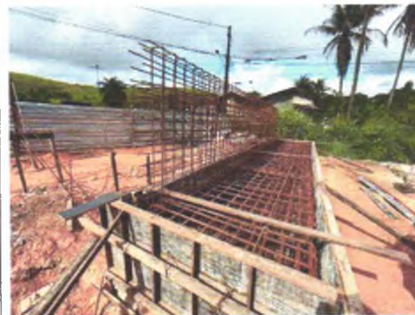
FOTO 12: FORMA DO BLOCO EXECUTADA;
