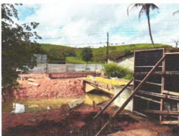
FOTO 5: FORMA DAS ALAS EXECUTADAS;
