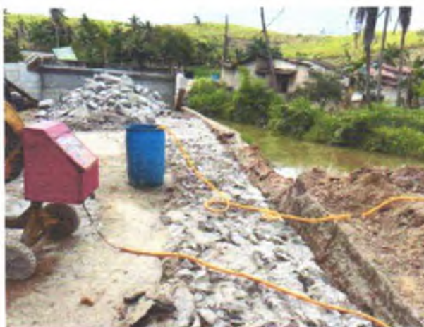
FOTO 09: MURO DE ARRIMO EM EXECUÇÃO;
