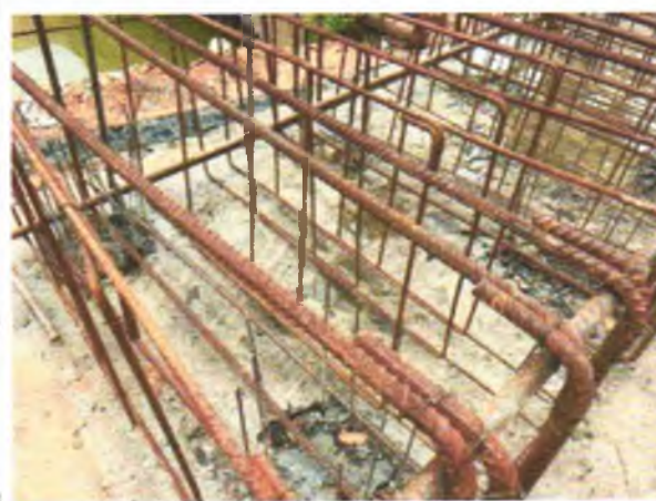
FOTO 2: ARMADURA DOS BLOCOS EXECUTADAS;
