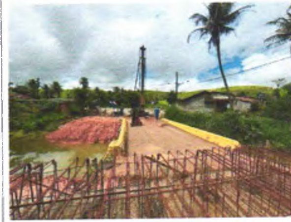
FOTO 6: ARMADURA DOS BLOCOS EXECUTADAS;
