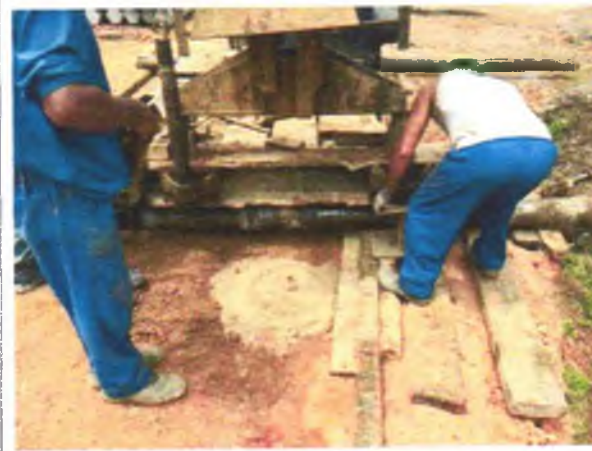
FOTO 4: CRAÇÃO DAS ESTACAS DO BLOCO;
