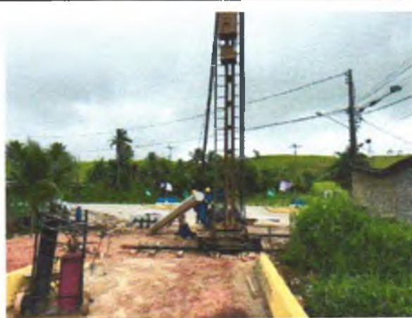
FOTO 1: CRAÇÃO DAS ESTACAS DO BLOCO;
