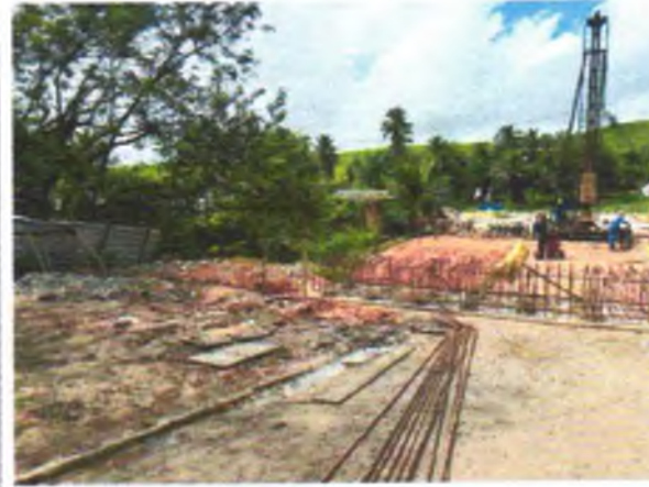
FOTO 12: ARMADURA DOS BLOCOS EXECUTADAS;
