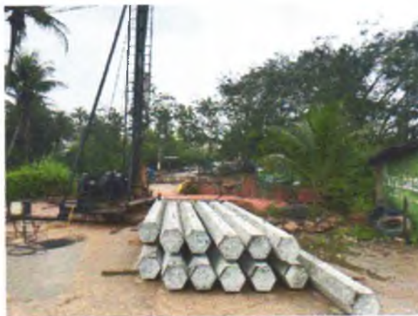
FOTO 11: ESTACAS PARA CRAVAÇÃO DO BLOCO;
