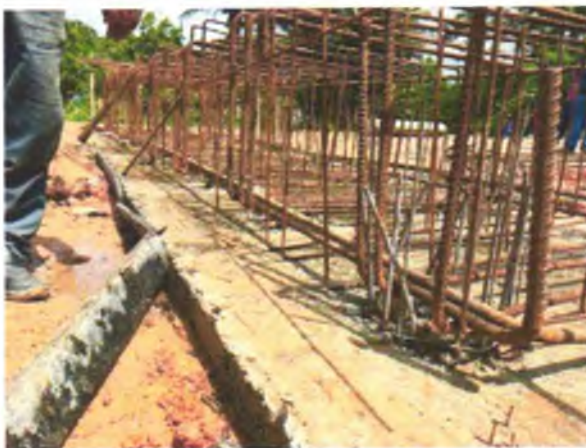
FOTO 09: ARMADURA DOS BLOCOS EXECUTADAS;
