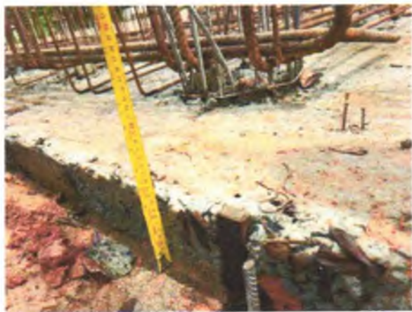
FOTO 7: LASTRO DE CONCRETO MAGRO EXECUTADO;
