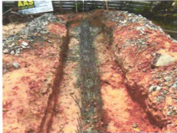
FOTO 8: ESTACAS DA CORTINA CRAVADAS;
