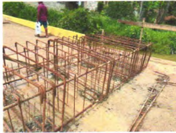
FOTO 10: ARMADURA DOS BLOCOS EXECUTADAS;
