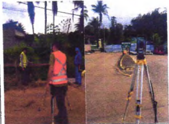
FOTO 12: LOCAÇÃO DA PONTE COM EQUIPAMENTOS TOPOGRÁFICOS;
