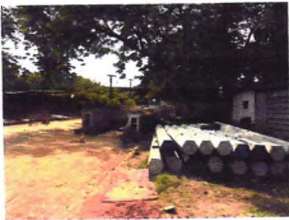
FOTO 09: ESTACAS DA FUNDAÇÃO 2º BLOCO;
