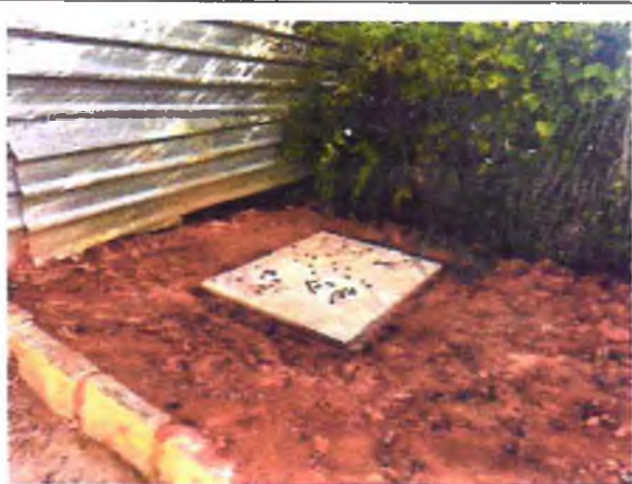
FOTO 1: CAIXA HIDRÁULICA EXECUTADA;
