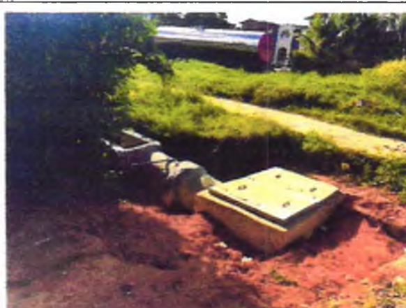
FOTO 2: CAIXA HIDRÁULICA EXECUTADA;
