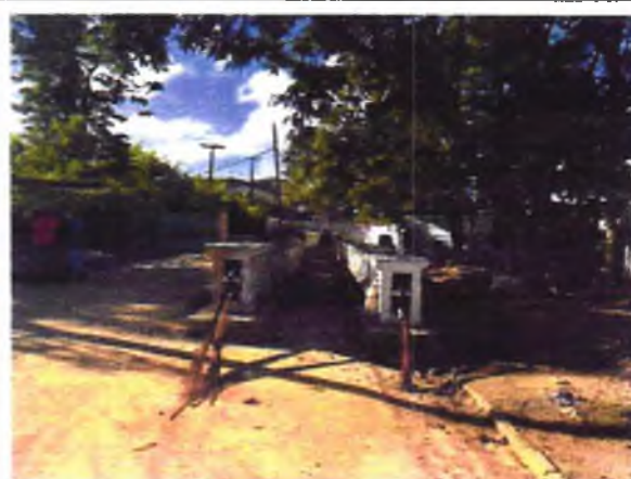
FOTO 4: LONGARINAS CONCRETADAS;
