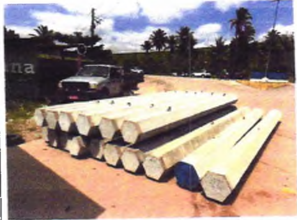
FOTO 8: 2ª ESTACAS DA FUNDAÇÃO 1º BLOCO;
