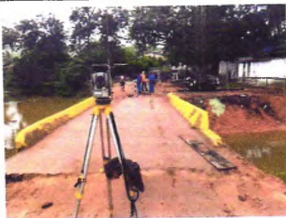
FOTO 11: LOCAÇÃO DA PONTE COM EQUIPAMENTOS TOPOGRÁFICOS;
