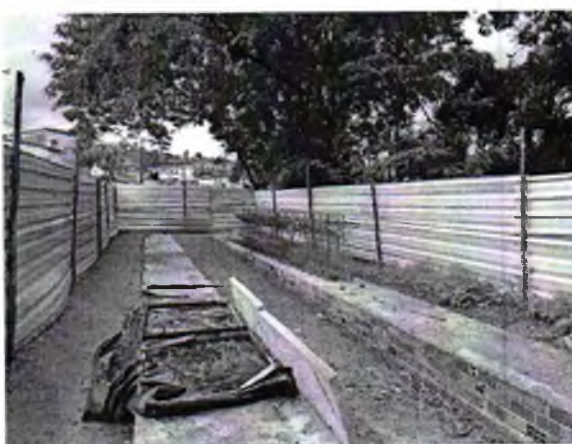
FOTO 09: MONTAGEM DA ARMAÇÃO DA 3 LONGARINA;
