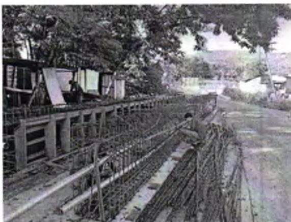
FOTO 5: MONTAGEM DA ARMADURA DA LONGARINA;
