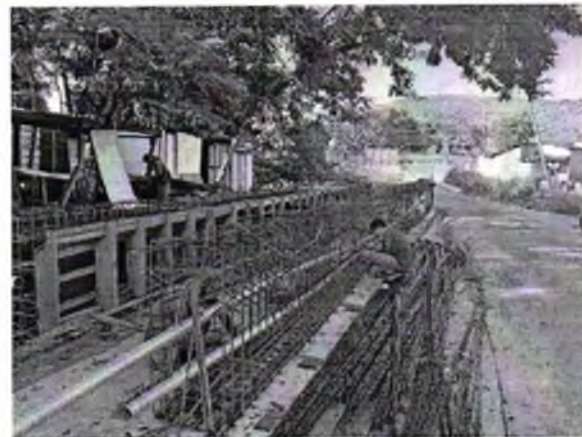
FOTO 6: MONTAGEM DA ARMADURA DA LONGARINA;
