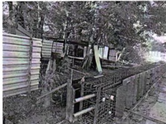
FOTO 4: MONTAGEM DA ARMADURA DA LONGARINA;
