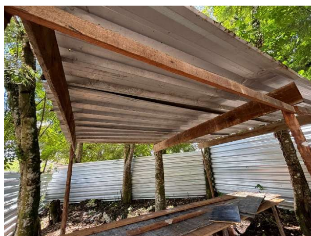
FOTO 4: COBERTA DA BANCADA DE FORMA;
