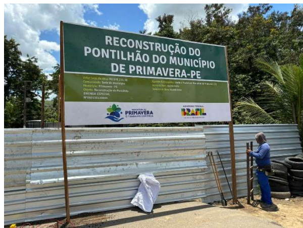
FOTO 1: PLACA DA OBRA;
