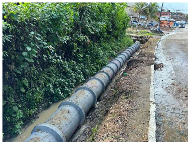
FOTO 12: TUBOS DE DRENAGEM EXECUTADOS;
