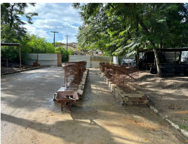
FOTO 09: ARMAÇÃO DAS LONGARINAS EXECUTADAS;
