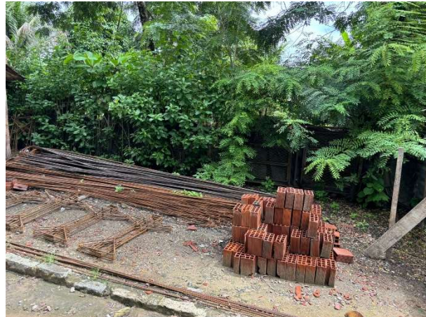
FOTO 8: DOBRA DO AÇO DAS LONGARINAS;
