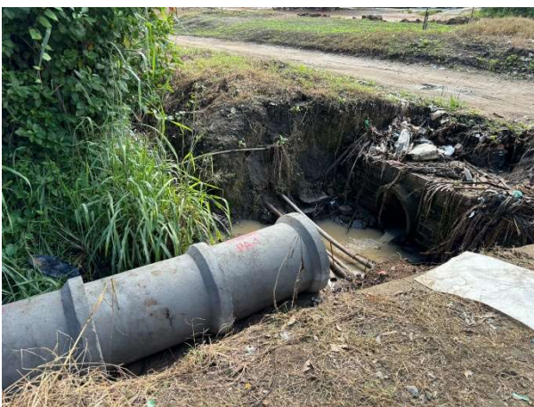
FOTO 11: TUBOS DE DRENAGEM EXECUTADOS;
