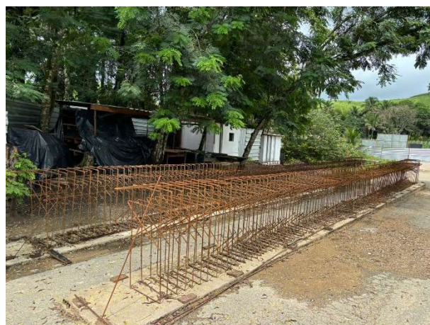
FOTO 10: ARMAÇÃO DAS LONGARINAS EXECUTADAS;
